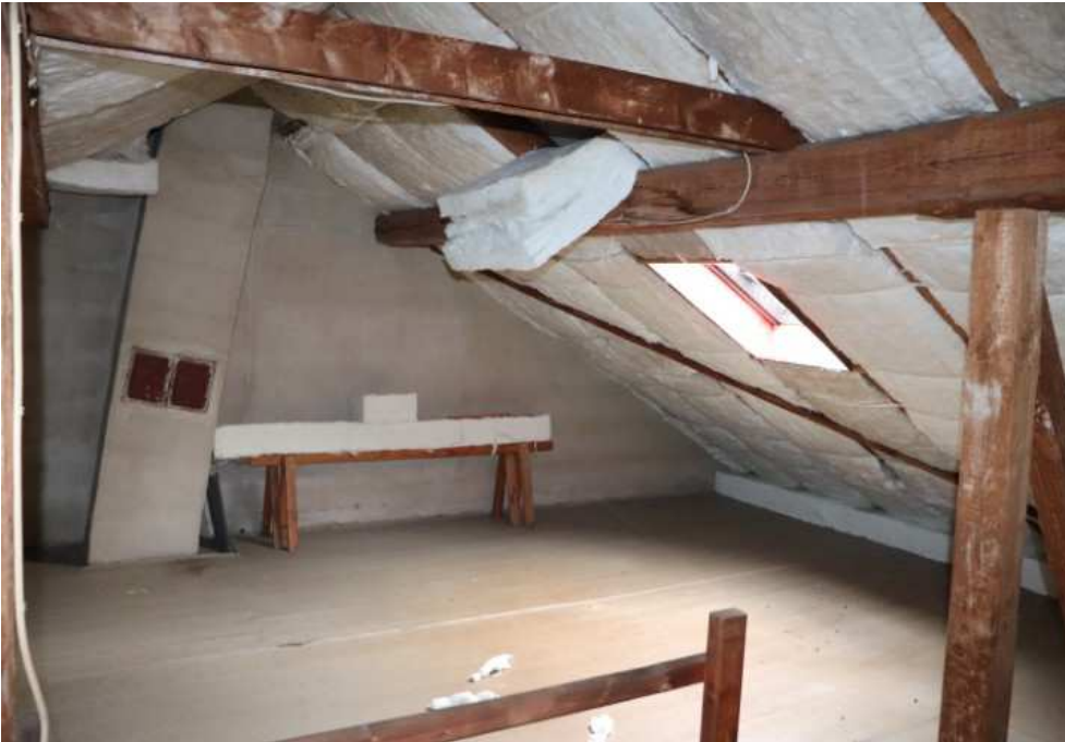
Bild 21 Dachgeschoss (nicht ausgebaut)
