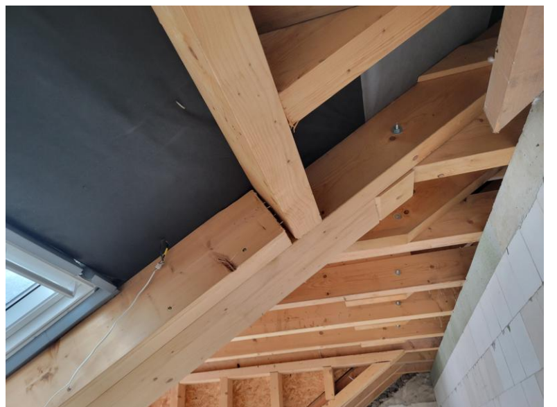
Unfachmännische Zimmermannskonstruktion
