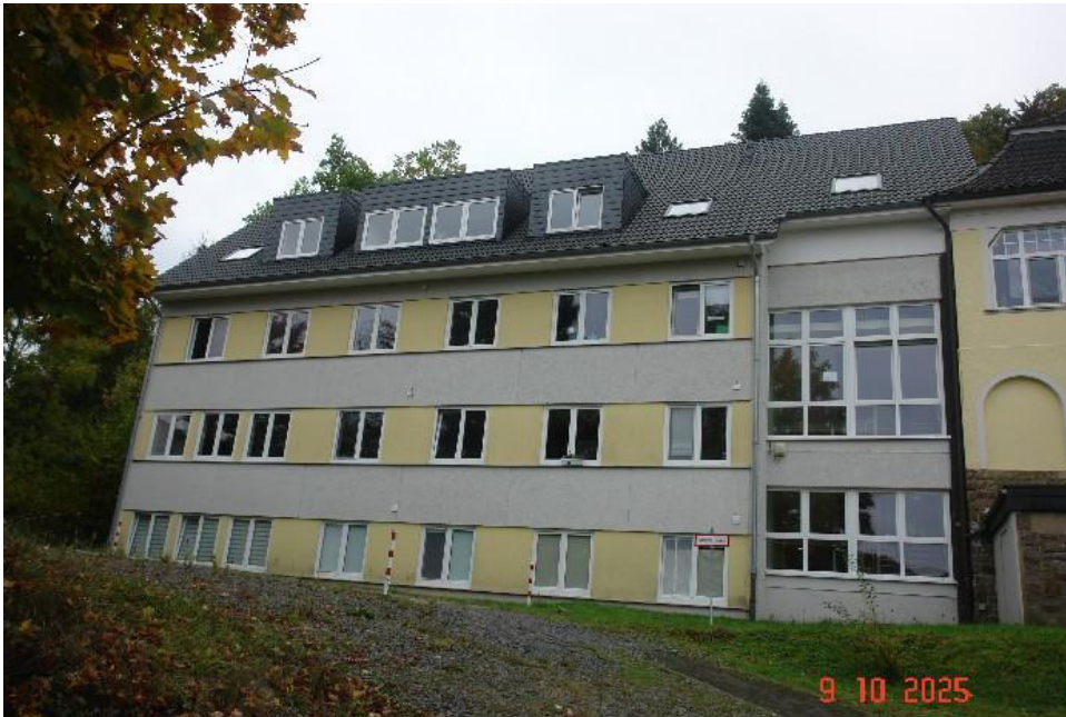
Bild 5: Ansicht des Bewertungsobjekts aus nordwestlicher Richtung
