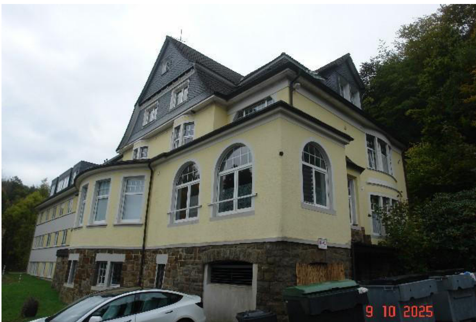
Bild 4: Ansicht des Bewertungsobjekts aus westlicher Richtung
