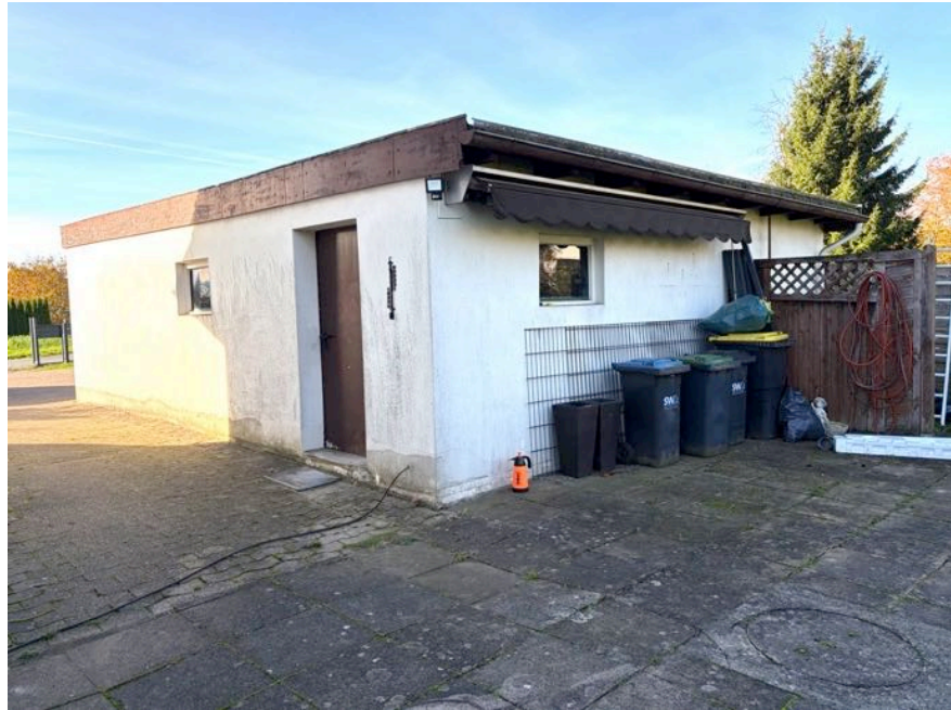
Nordostansicht der Garage
