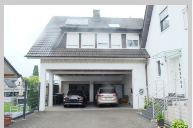
Garagen mit vorgelagertem überdachtem Außenstellplatz
