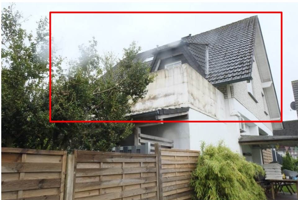
Bild 4: Blick auf das Garagengebäude mit Brüstung der Dachterrasse
