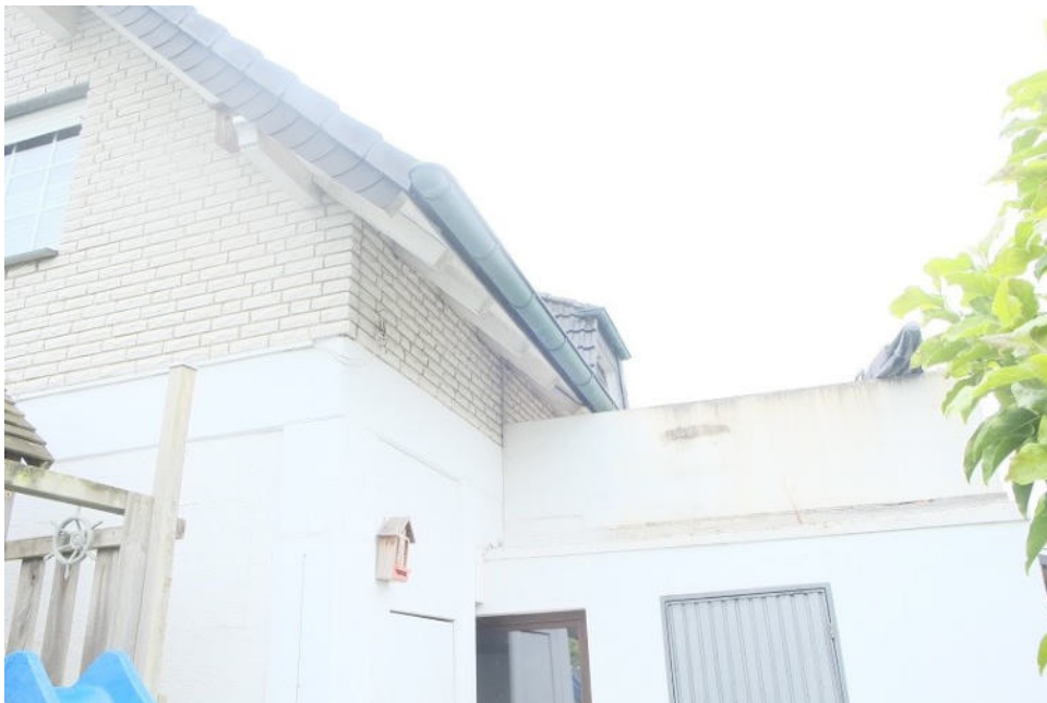
Bild 2: Ansicht von der Gartenseite mit Blick auf die Terrasse über der Garage
