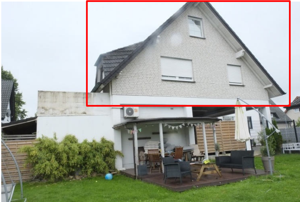
Bild 3: Blick auf die Fassade mit Überbau auf das Flurstück 35/3
