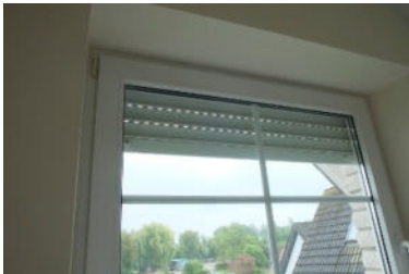
Giebelfenster im Spitzboden
