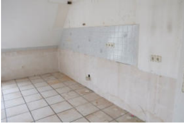
Küche im Dachgeschoss
