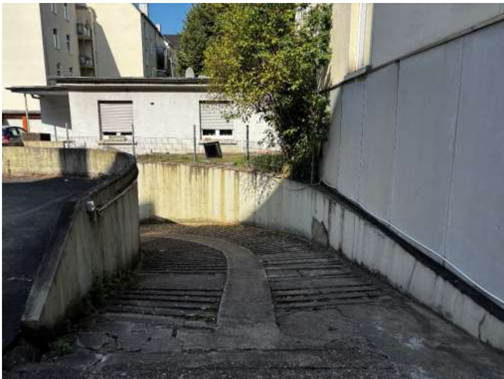
Zufahrt zur Tiefgarage
