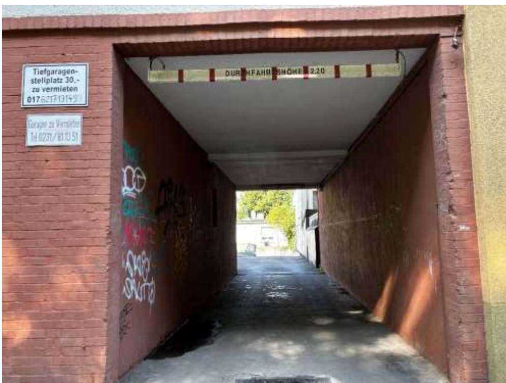
Durchfahrt zum Hof, den Garagen und der Tiefgarage
