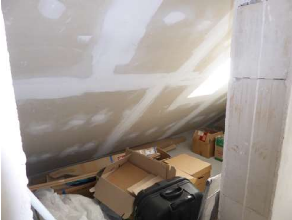
DG: nicht ausgebauter Dachraum
