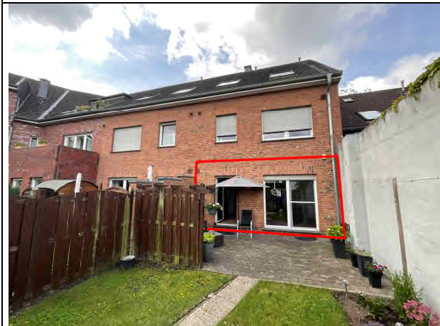
Foto 3: Blick aus nordöstlicher Richtung auf das Mehrfamilienwohnhaus
