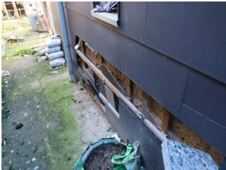
Bild 5 Außenansicht seitlicher Durchgang
