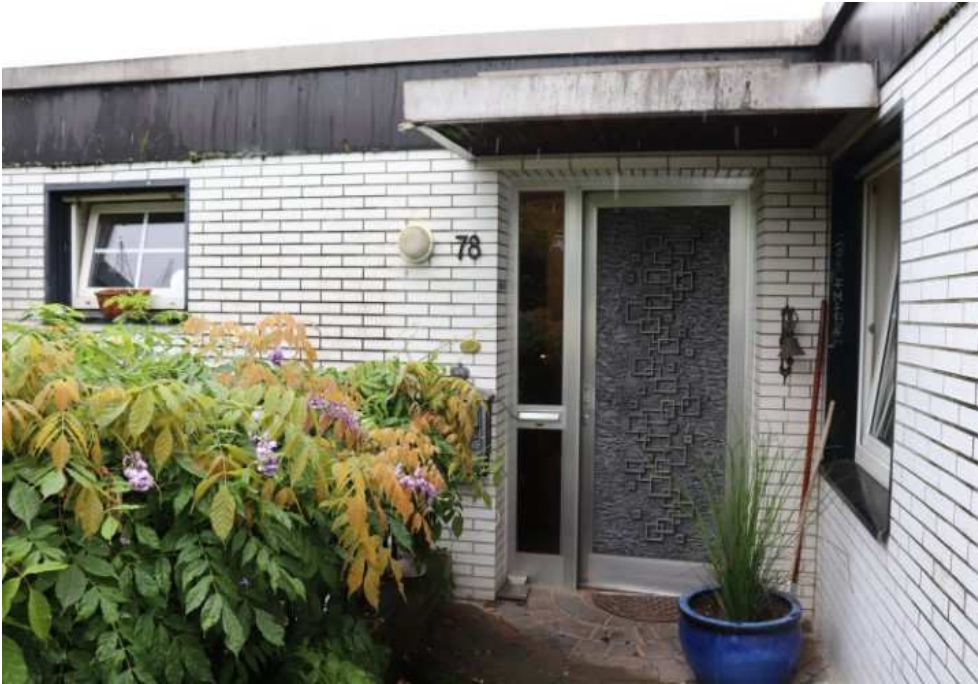
Bild 5 Vorderansicht mit Hauseingang
