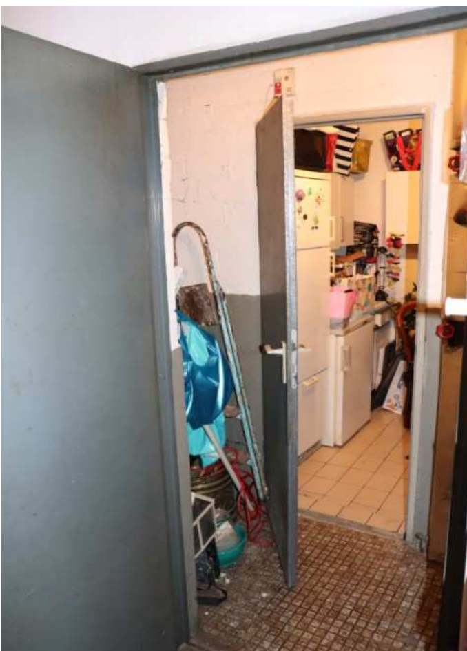
Bild 10 Untergeschoss, Kellerbereich -Heizungsraum-
