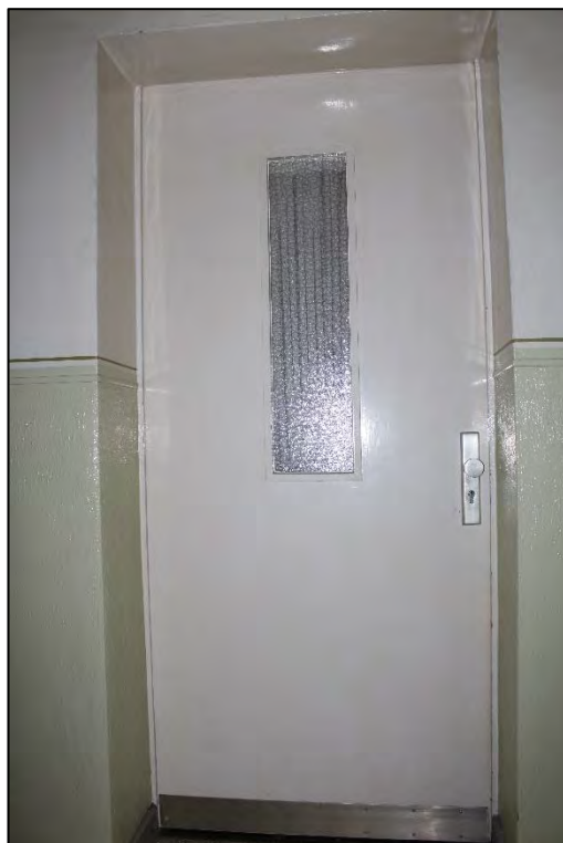
Foto Nr. 38: Gemeinschaftstreppehaus, 1. OG, Eingang WE Nr. 2
