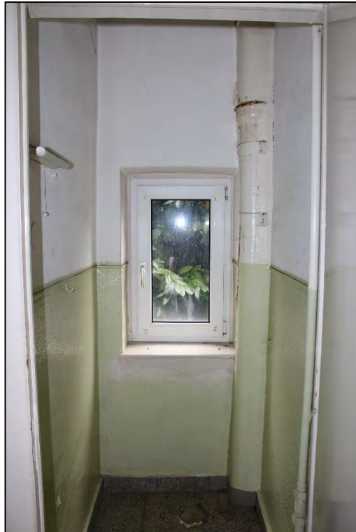
Foto Nr. 37: Gemeinschaftstreppehaus, Treppenpodest, Abstellraum
