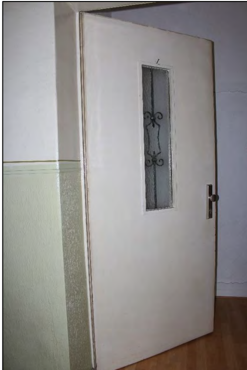
Foto Nr. 43: Gemeinschaftstreppehaus, 2. OG, Eingang WE Nr. 3
