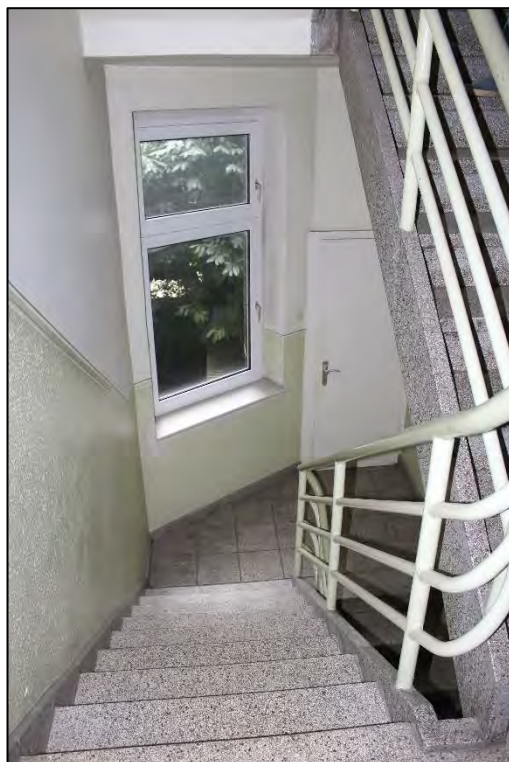
Foto Nr. 40: Gemeinschaftstreppehaus, Treppe zum 2. OG
