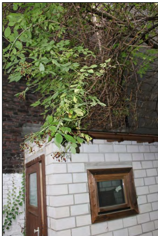
Foto Nr. 10: Anbau
