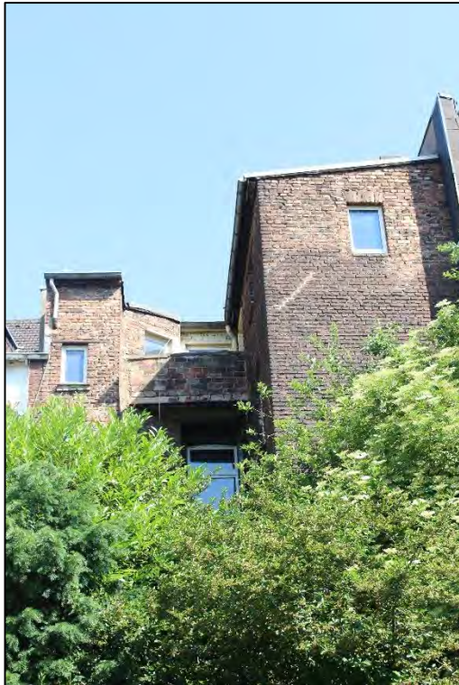
Foto Nr. 3: Hoffassade
