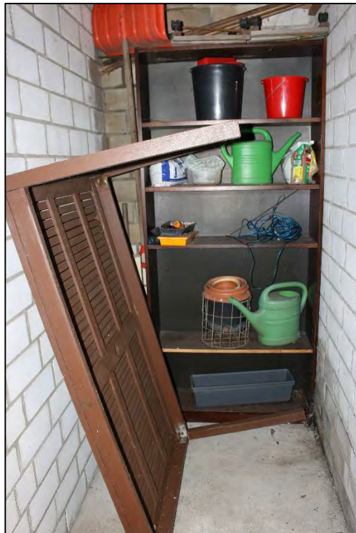
Foto Nr. 11: Anbau, innen
