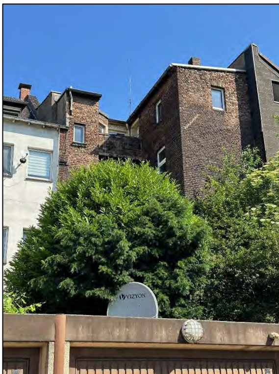
Foto Nr. 4: Hoffassade
