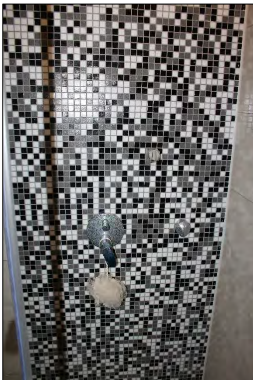
Foto Nr. 32: Erdgeschoss, WE Nr. 1, Duschbad
