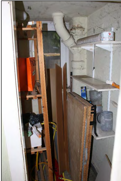
Foto Nr. 15: Gemeinschaftstreppe, Erdgeschoss, Abstellraum
