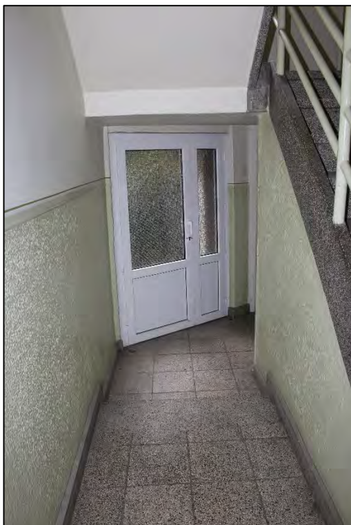
Foto Nr. 14: Gemeinschaftstreppehaus, Erdgeschoss, Hofausgang
