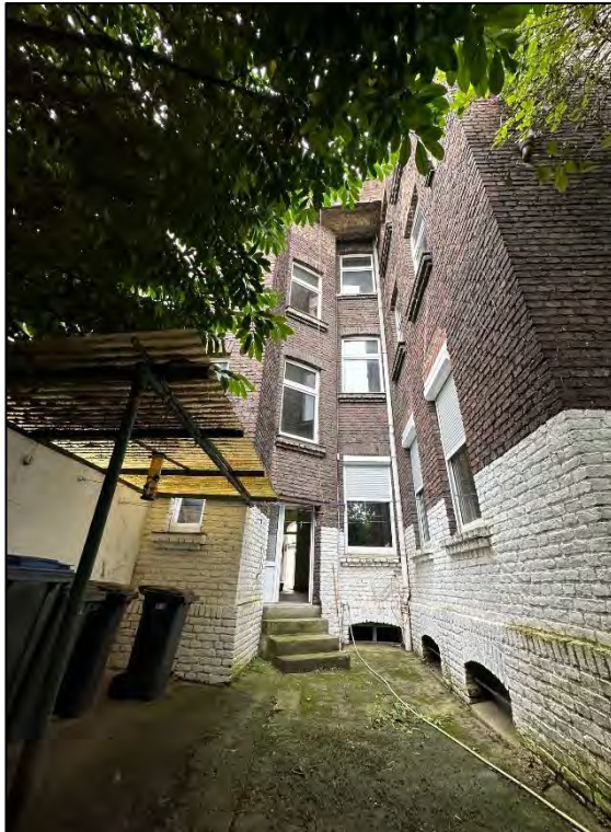
Foto Nr. 7: Gartenfassade / Hofraum
