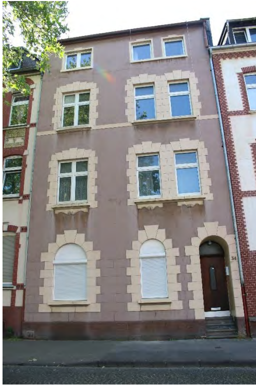
Foto Nr. 1: Straßenfassade
