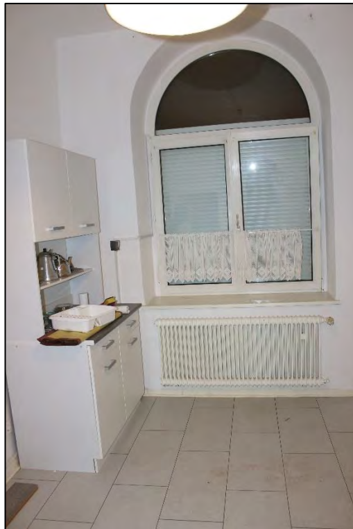
Foto Nr. 29: Erdgeschoss, WE Nr. 1, Küche
