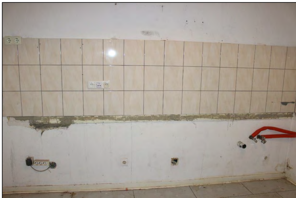
Foto Nr. 30: Erdgeschoss, WE Nr. 1, Küche
