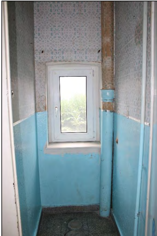
Foto Nr. 41: Gemeinschaftstreppehaus, Treppenpodest, Abstellraum
