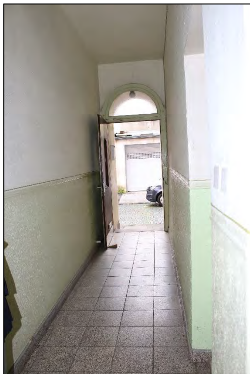
Foto Nr. 12: Gemeinschaftstreppe, Erdgeschoss, Hauseingang
