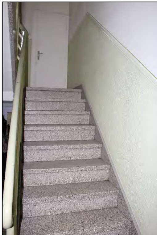
Foto Nr. 36: Gemeinschaftstreppe, Treppe zum 1. OG
