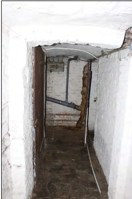
Foto Nr. 21: Kellergeschoss, Flur
