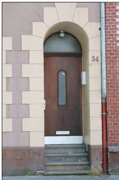
Foto Nr. 2: Hauseingang
