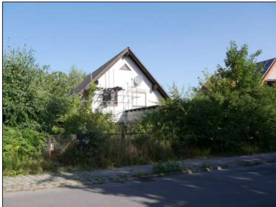
Blick nach Norden auf die straßenseitige Front des Grundstücks Busonistr. 45 mit auf dem Grundstück aufstehendem Einfamilienhaus nebst davor belegenem Doppelgaragen-Anbau
