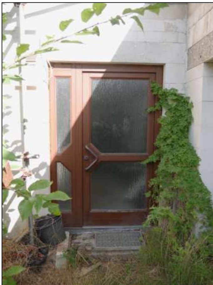
Hauseingangstür neben dem Doppelgaragen-Anbau in der straßenseitigen Giebelseite des Einfamilienhauses
