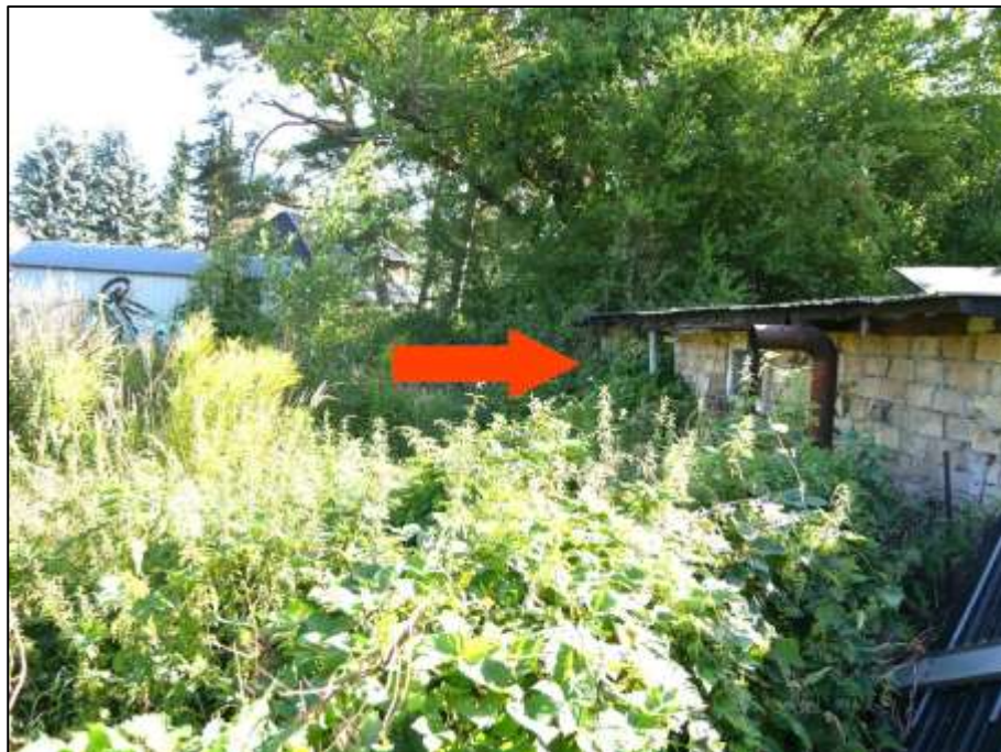
Lage des rückwärtig an den „Platz A“ angrenzenden Grundstücks Busonistr. 45 (Pfeil)
