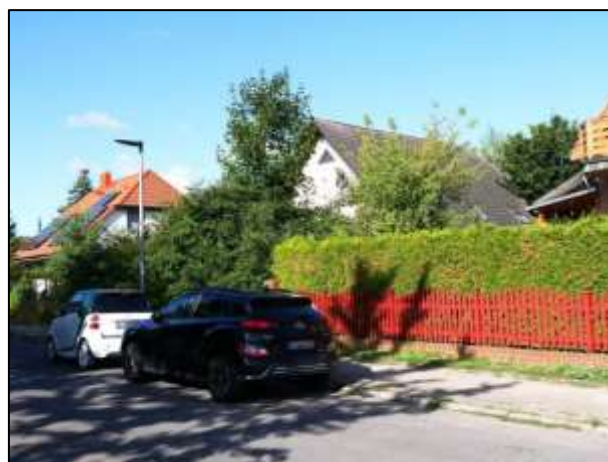
EFH auf dem Grundstück Busonistraße 45
