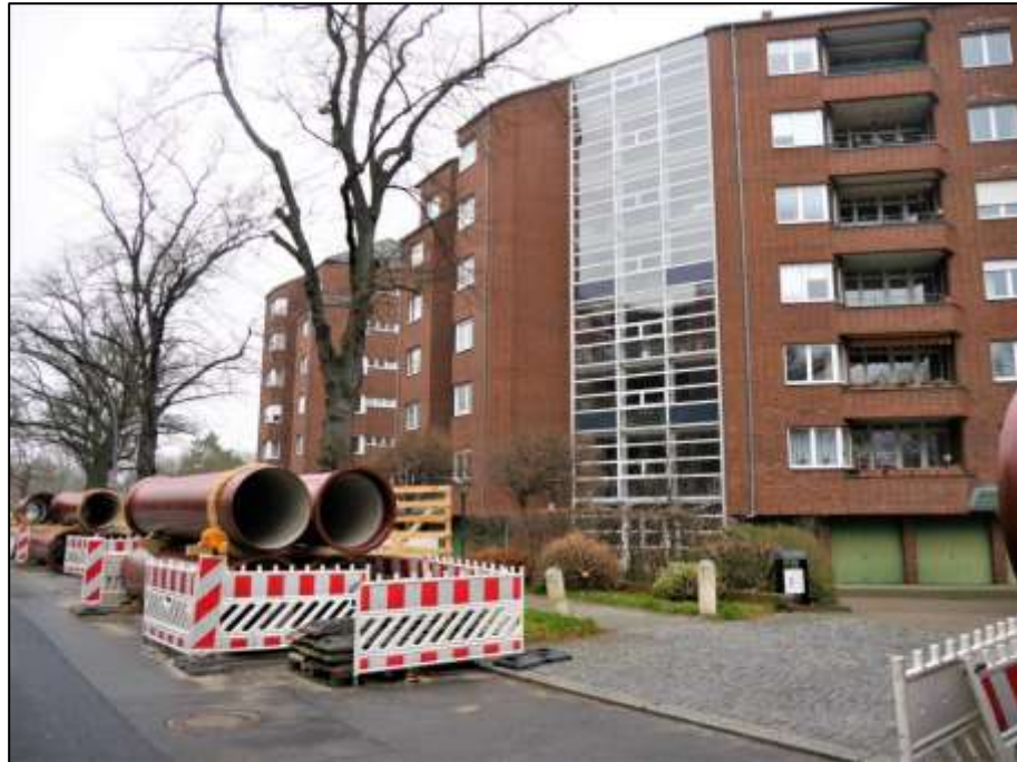
Blick aus der Hermsdorfer Straße auf den Gebäudeteil Hermsdorfer Straße 32 mit davor belegener Rampe zu den in den nominellen Untergeschossen belegenen ebenerdig anzufahrenden Garagen innerhalb der Wohnhauszeile sowie in den davor belegenen separaten 1-geschossigen Garagenzeilen
