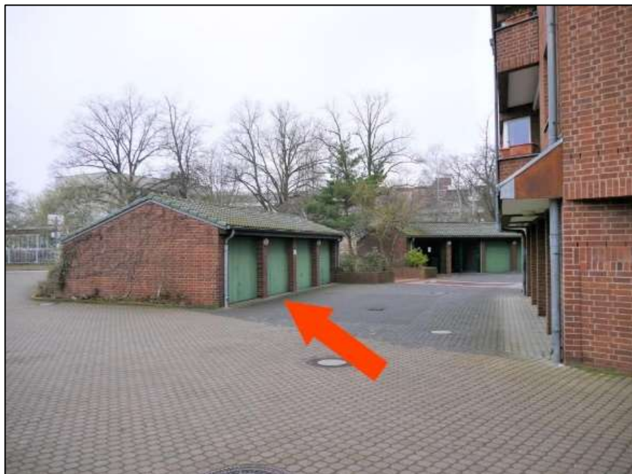
Blick aus dem Bereich des Gebäudeteils Nr. 25 nach Nord-Westen in den Zufahrtkorridor zu den Einzelgaragen bzw. als Feuerwehrezufahrt mit separater Garagenzeile und Lage der mit einem SNR zugunsten des hier betroffenen Wohnungseigentums Nr. 9 belegten Garage Nr. 9
