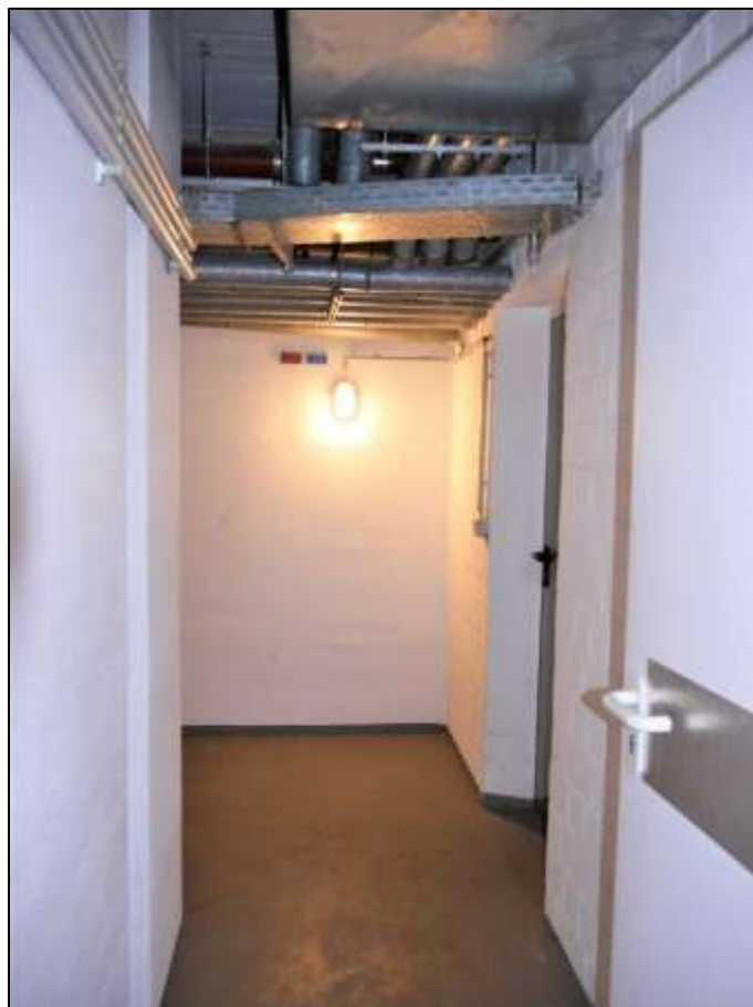
nominelles Untergeschoss im ebenerdig zugänglichen Eingangsgeschoss mit an den Zentralflur im linken Gebäudeteil des Hauses Nr. 25 anbindenden haustechnischen Räumen
