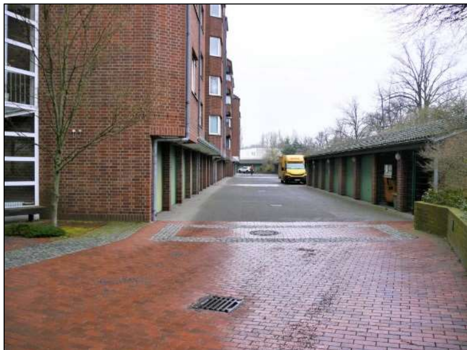
Blick aus dem Bereich des Gebäudeteils Nr. 28 nach Süden in den Zufahrtkorridor zu den im Untergeschoss der Wohnhauszeile und den separaten Garagenzeilen belegenen Einzelgaragen bzw. der Feuerwehrezufahrt mit Aufstellfläche
