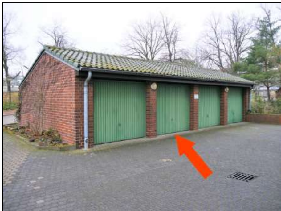
Blick auf die vor dem Gebäudeteil Hermsdorfer Str. 25 belegene Garagenzeile mit 4 Einzelgaragen u.a. als Sondernutzungsrecht (Garage Nr. 9) zugunsten des hier betroffenen Wohnungseigentums Nr. 9 als 2 Garage von links bzw. vor der südlichen Kopfseite (Pfeil)
