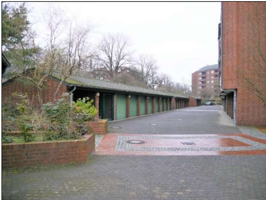
Blick aus dem Bereich des Gebäudeteils Nr. 25 nach Norden in den Zufahrtkorridor zu den Einzelgaragen bzw. als Feuerwehrezufahrt mit separaten Garagenzeilen links und im Untergeschoss der Wohnhauszeile belegenen weiteren Garagen - links Zuwegung von der Straße
