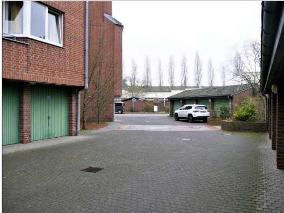
Blick aus dem Bereich des Gebäudeteils Nr. 26 nach Süden in den Zufahrtkorridor zu den Einzelgaragen bzw. als Feuerwehrezufahrt mit separater Garagenzeile vor der südlichen Grundstücksgrenze im Hintergrund u.a. mit SNR an der Garage Nr. 9 des hier betroffenen Wohnungseigentums
