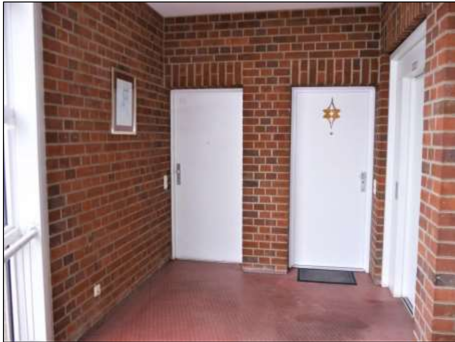
Treppenhaus mit nomineller 2. Obergeschoss-Ebene im Gebäudeteil Hermsdorfer Str. 25 und Lage des Wohnungseigentums Nr. 9 links im Bild
