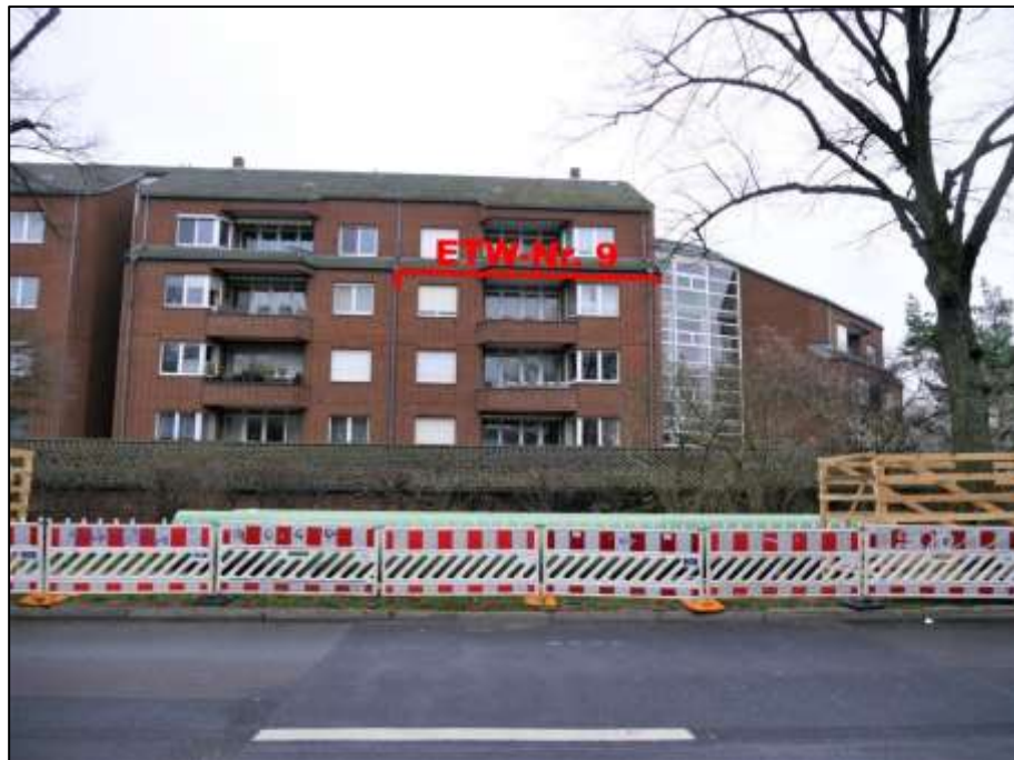
Blick über die Hermsdorfer Straße nach Osten mit Lage des auf dem Grundstück Hermsdorfer Straße 25, 26, 27, 28, 29, 30, 31, 32 und Cyclopstraße 23, 25, 27 (Flurstück 738) aufstehenden Gebäudeteils Hermsdorfer Str. 25 mit im nominell 2.OG belegener ETW-Nr. 9
