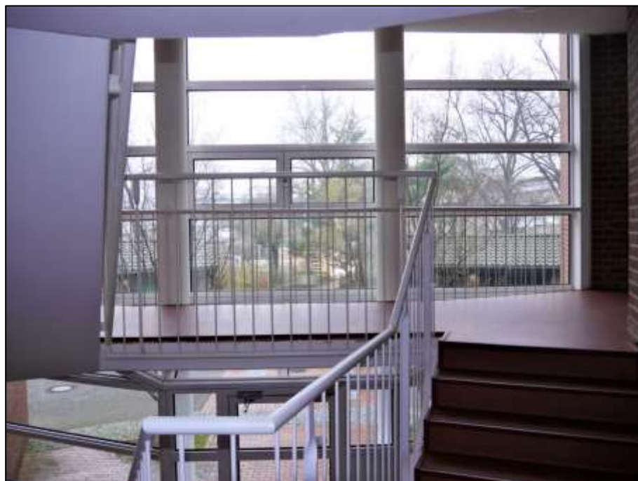
Treppenaustritt im nominellen Erdgeschoss des Gebäudeteils Hermsdorfer Str. 25
