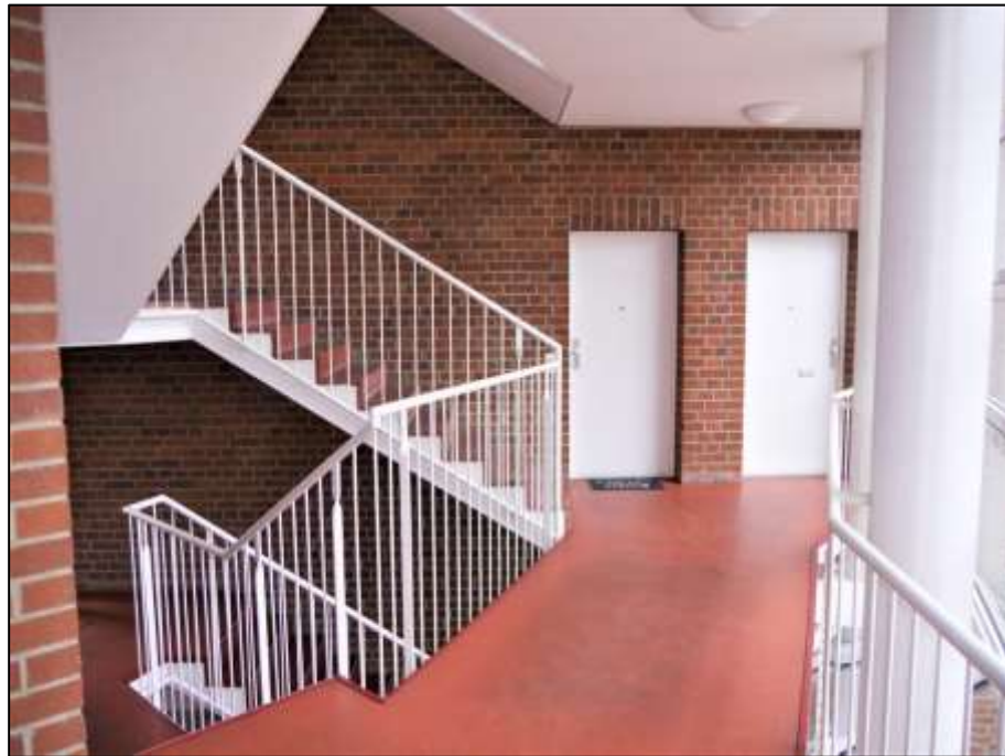
Treppenhaus mit nomineller Erdgeschoss-Ebene im Gebäudeteil Hermsdorfer Str. 25
