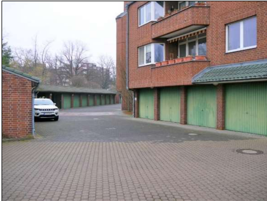
Blick aus dem Bereich des Gebäudeteils Nr. 25 nach Norden in den Zufahrtkorridor zu den Einzelgaragen bzw. als Feuerwehrezufahrt mit separaten Garagenzeilen links und im Untergeschoss der Wohnhauszeile belegenen weiteren Garagen
