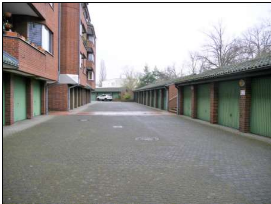
Blick aus dem Bereich des Gebäudeteils Nr. 27 nach Süden in den Zufahrtkorridor zu den Einzelgaragen bzw. als Feuerwehruzufahrt
