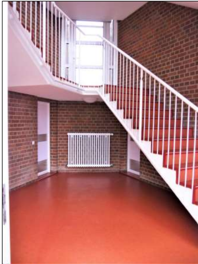
Hauseingangsbereich des Gebäudeteils Hermsdorfer Str. 25 im nominellen ebenerdig aus dem Freien vor der Hauseingangsfront zugänglichen Untergeschoss
