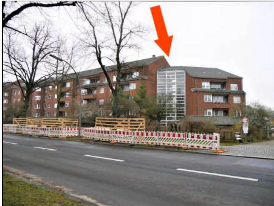
Blick über die Hermsdorfer Straße nach Nord-Osten mit Lage des auf dem Grundstück Hermsdorfer Straße 25, 26, 27, 28, 29, 30, 31, 32 und Cyclopstraße 23, 25, 27 (Flurstück 738) aufstehenden Gebäude- teils Hermsdorfer Str. 25 (Pfeil)
