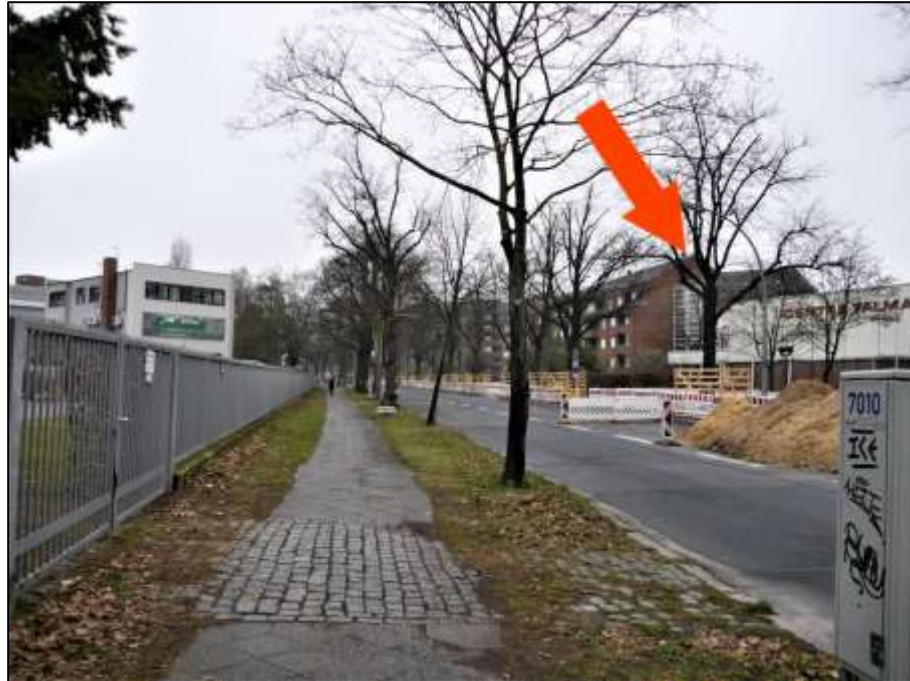
Blick in die Hermsdorfer Straße nach Norden mit Lage des auf dem Grundstück Hermsdorfer Straße 25, 26, 27, 28, 29, 30, 31, 32 und Cyclopstraße 23, 25, 27 (Flurstück 738) aufstehenden Gebäudeteils Hermsdorfer Str. 25 (Pfeil)
