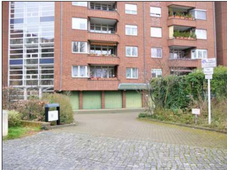
Blick aus dem Straßenraum auf die Rampe zu den Garagenstellplätzen innerhalb der Wohnhauszeile sowie in den davor belegenen separaten 1-geschossigen Garagenzeilen im Bereich des Gebäudeteils Hermsdorfer Str. 30
