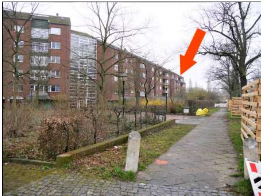
Blick über den Bürgersteig der Hermsdorfer Straße nach Süden mit Lage des auf dem Grundstück Hermsdorfer Straße 25, 26, 27, 28, 29, 30, 31, 32 und Cyclopstraße 23, 25, 27 (Flurstück 738) aufstehenden Gebäudeteils Hermsdorfer Str. 25 (Pfeil)
