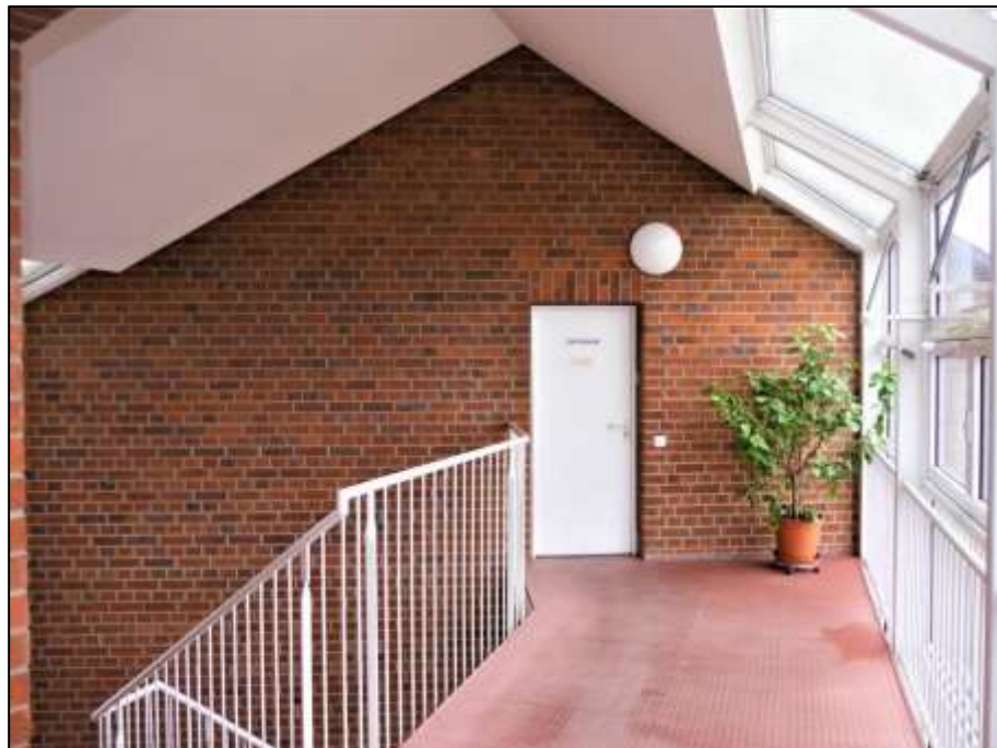
Dachbodenzugang aus der nominell 2. Obergeschoss-Ebene in den Dachraum im 4\frac{1}{4} -geschossigen Teil des Gebäudeteils Hermsdorfer Str. 25
