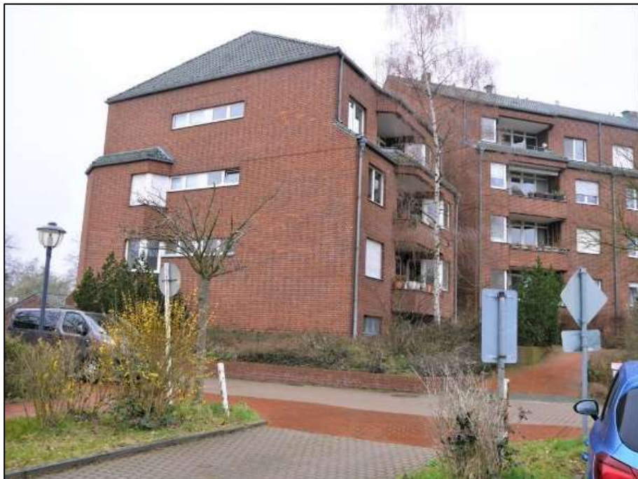
Blick von dem südlich angrenzenden Nachbargrundstück auf die freie Giebelseite des Gebäudeteils Hermsdorfer Str. 25
