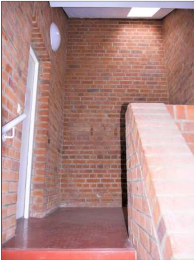
Treppenhauskopf des separaten Treppentriegelstiegenhauses zum Dachboden mit Zugang zu den dort belegenen Bodenkammern u.a. mit Nr. 9 als SNR zugunsten der ETW-Nr. 9 im 5½-geschossigen Teil des Gebäudeteils Hermsdorfer Str. 25
