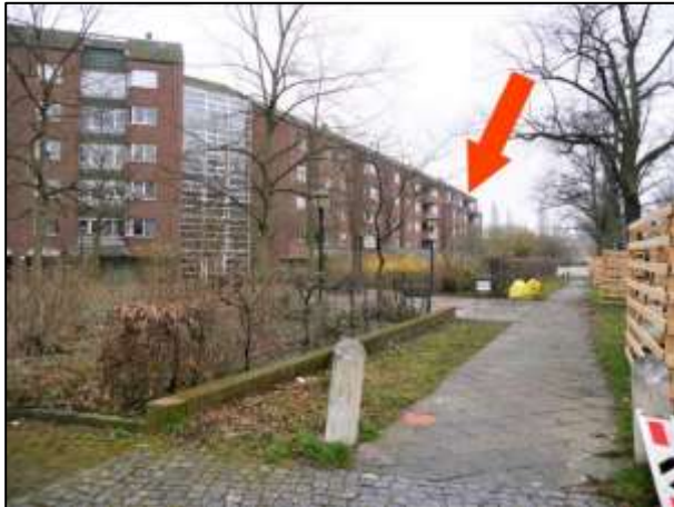
Hermisdorfer Straße 25-31 (Pfeil: Hs.-Nr. 25)
