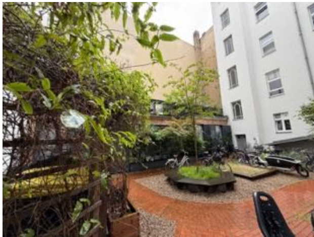
rückwärtige Fassade (Wohnung Nr. 18 markiert)
