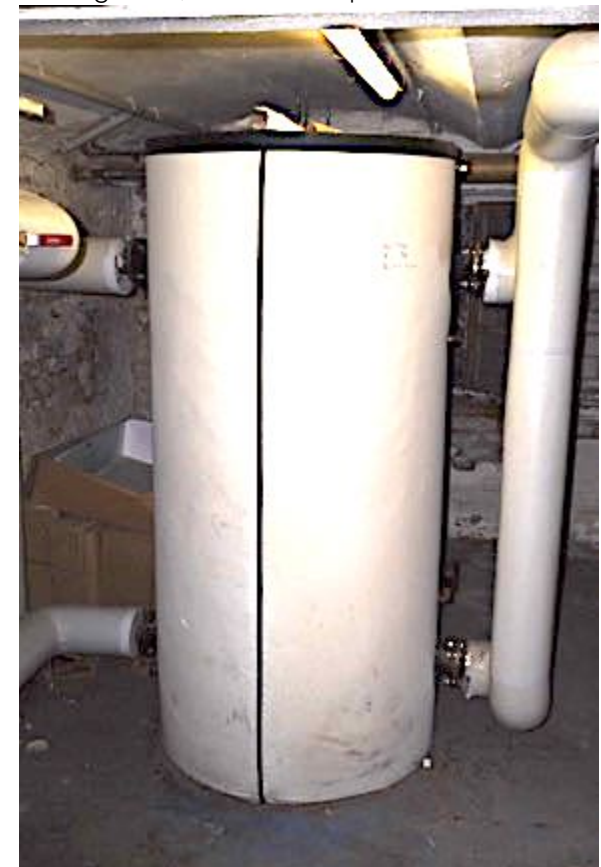
Heizungsraum, Warmwasserspeicher
