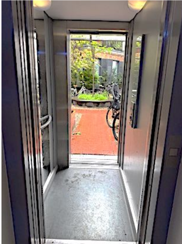
Aufzug, Ausgang Innenhof.
