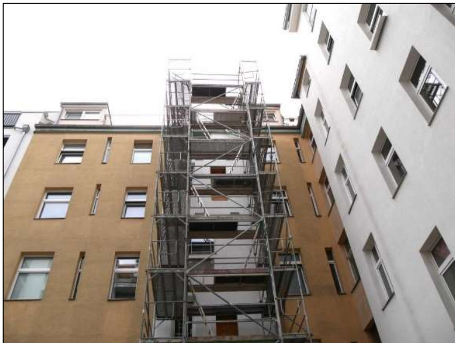
Blick aus dem Hof des Anwesens auf die Obergeschosse des Vorderhauses mit Gauben im Dachgeschoss sowie rechts im Bild anbindendem linken Seitenflügel mit geschosshoch aufgehendem Drempel im Bereich des aufgestockten Dachgeschosses
