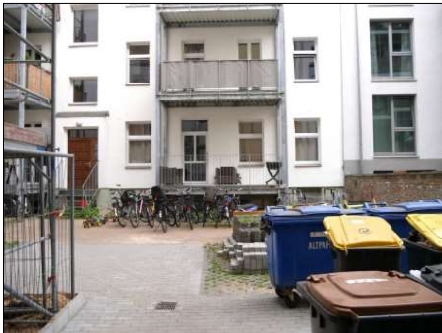
Blick aus der Gebäudedurchfahrt im Vorderhaus auf die hofseitige Front des Quergebäudes im Bereich der Erdgeschosszone
