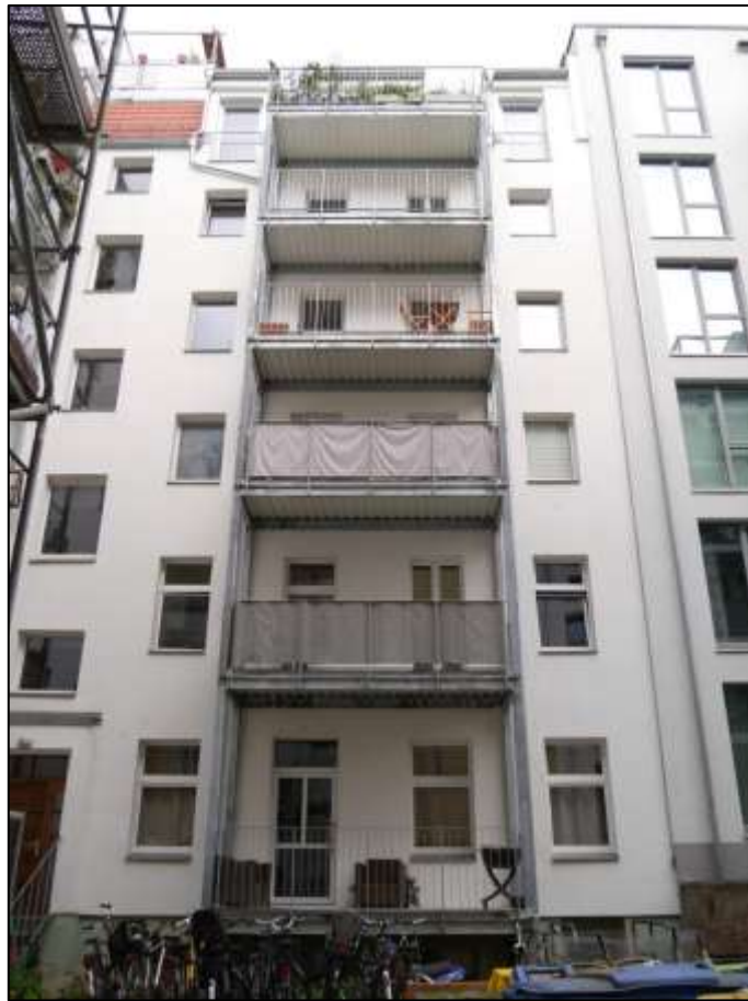
Blick aus der Gebäudedurchfahrt im Vorderhaus auf die hofseitige Front des Quergebäudes
