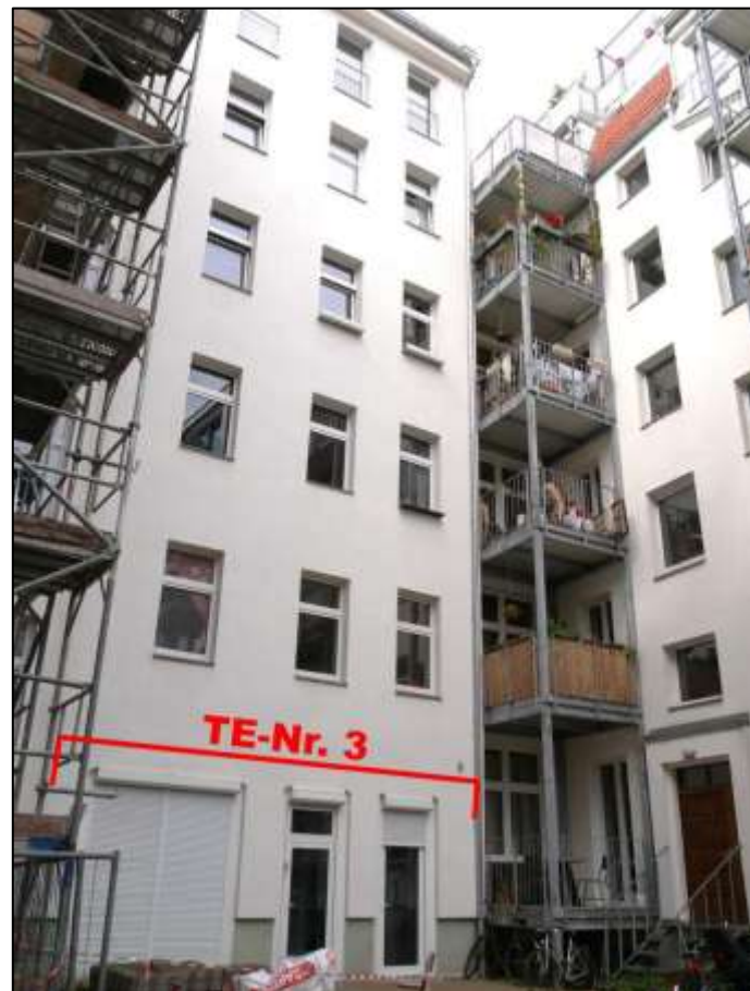
Blick aus dem Bereich der Gebäudedurchfahrt des Vorderhauses auf die hofseitigen Fronten des linken Seitenflügels und des rechts im Bild anbindenden Quergebäudes mit Lage des Teileigentums Nr. 3 im Erdgeschoss
