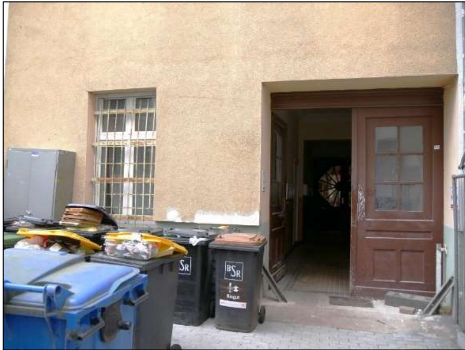
hofseitige Front des Vorderhauses im Bereich der Doppelflügeltoranlage zur Gebäudedurchfahrt
