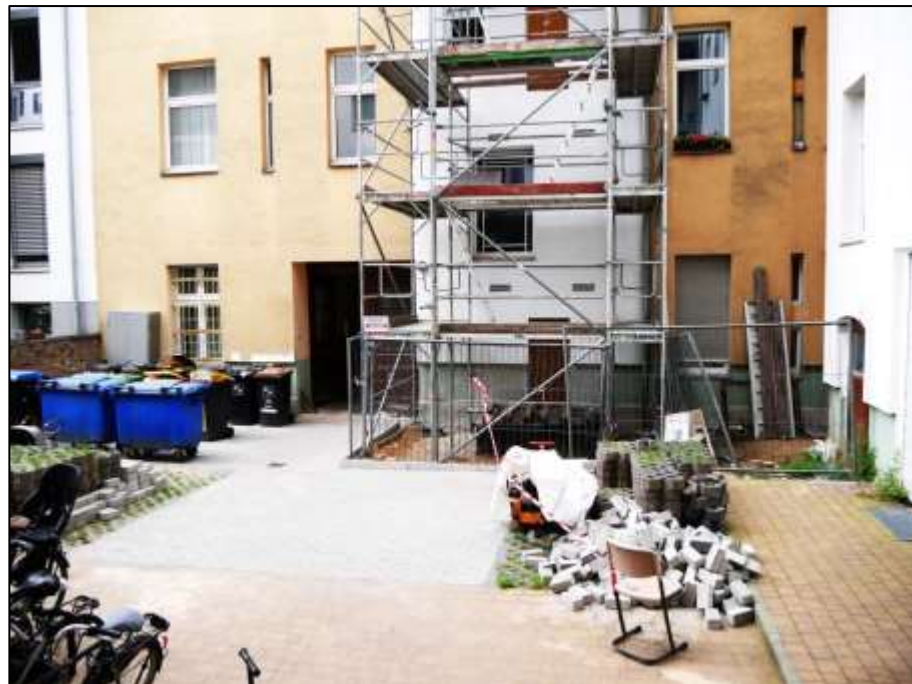
Blick von der Differenztreppe zum Treppenhaus des Quergebäudes über den Hof auf die Erdgeschosszone des Vorderhauses
