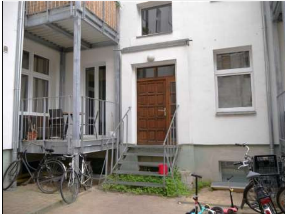
hofseitigen Fronten des linken Seitenflügels links im Bild und des hieran rechts anbindenden Quergebäudes im Bereich des Hochparterres und des darunter belegen Souterrains sowie Differenzterasse zum Hochparterre mit anbindendem Quergebäudetreppenhaus
