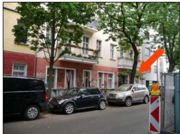
Gebäudedurchfahrt a.d. Grdst. Kreutzigerstr. 5
