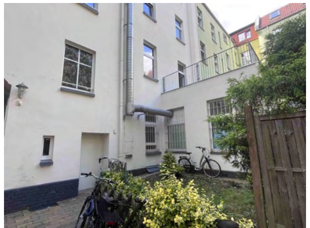
Abb. 12 Anbau EG Vorderhaus (Gewerbeeinheit)
