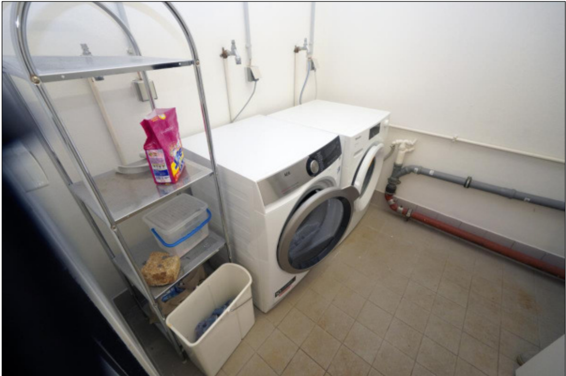
Waschmaschinenraum Nr. 1U08.2
