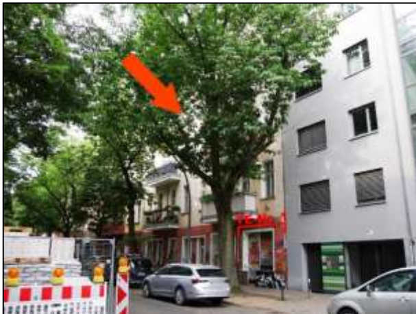
straßenseitige Gebäudefront mit TE-Nr. 1
