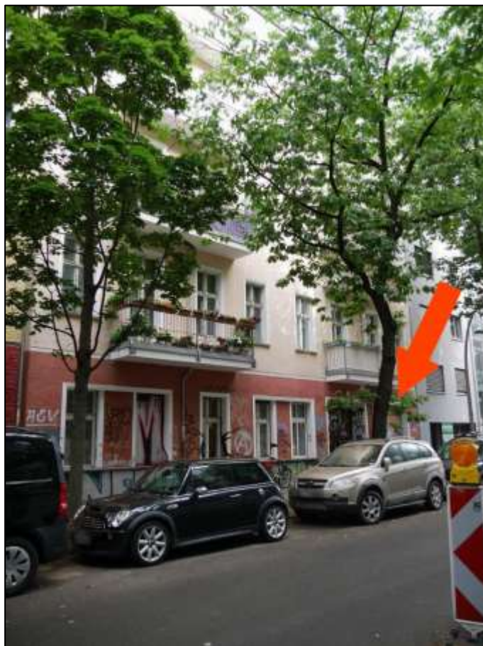
straßenseitige Front des Vorderhauses auf dem Grundstück Kreutzigerstraße 5 mit Lage des Teileigentums Nr. 1 im Erdgeschoss postalisches rechts (Pfeil)
