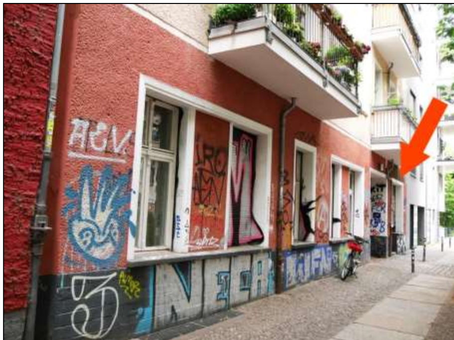
straßenseitige Front des Vorderhauses auf dem Grundstück Kreutzigerstraße 5 im Bereich der Erdgeschosszone mit Lage des Teileigentums Nr. 1 im Erdgeschoss postalisch rechts (Pfeil)
