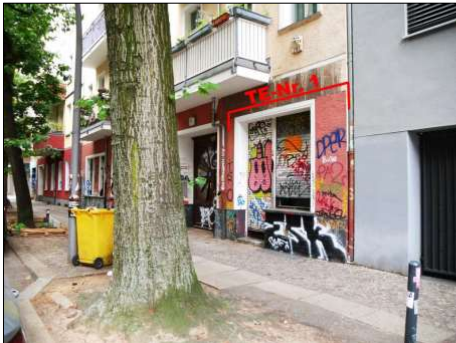
straßenseitige Front des Vorderhauses auf dem Grundstück Kreutzigerstraße 5 im Bereich der Erdgeschosszone mit Teileigentum Nr. 1
