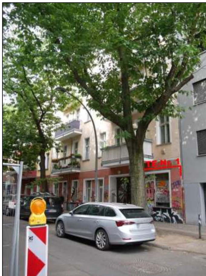
straßenseitige Front des Vorderhauses auf dem Grundstück Kreuzigerstraße 5 mit Lage des Teileigentums Nr. 1 im Erdgeschoss postalisch rechts
