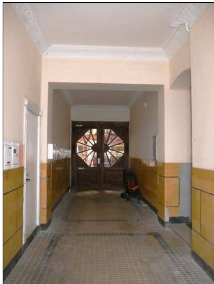
Blick in die Gebäudedurchfahrt des Vorderhauses in Richtung der straßenseitigen Toranlage mit rechts im Bild abgehendem Treppenhauszugang - links im Bild anbindendes Teileigentum Nr. 1
