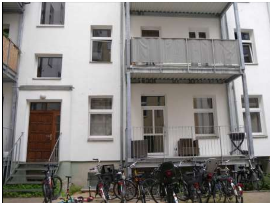
hofseitige Front des Quergebäudes im Bereich des Hochparterres und des Souterrains mit Differenzterasse zum Hochparterre mit anbindendem Quergebäudetreppenhaus
