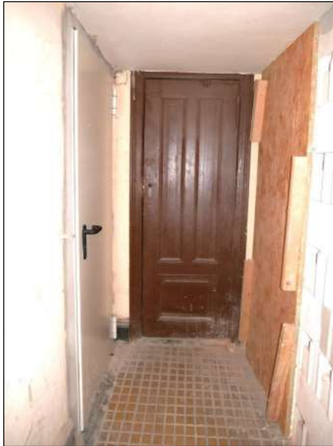
Blick aus der Gebäudedurchfahrt im Vorderhaus in den hieraus abgehenden Stichflur zu einem vorgesehenen Zugang eines sogen. Fassadenaufzugs und dem Kellertreppenabgang im Hintergrund sowie links im Bestand anbindender Abstellkammer
