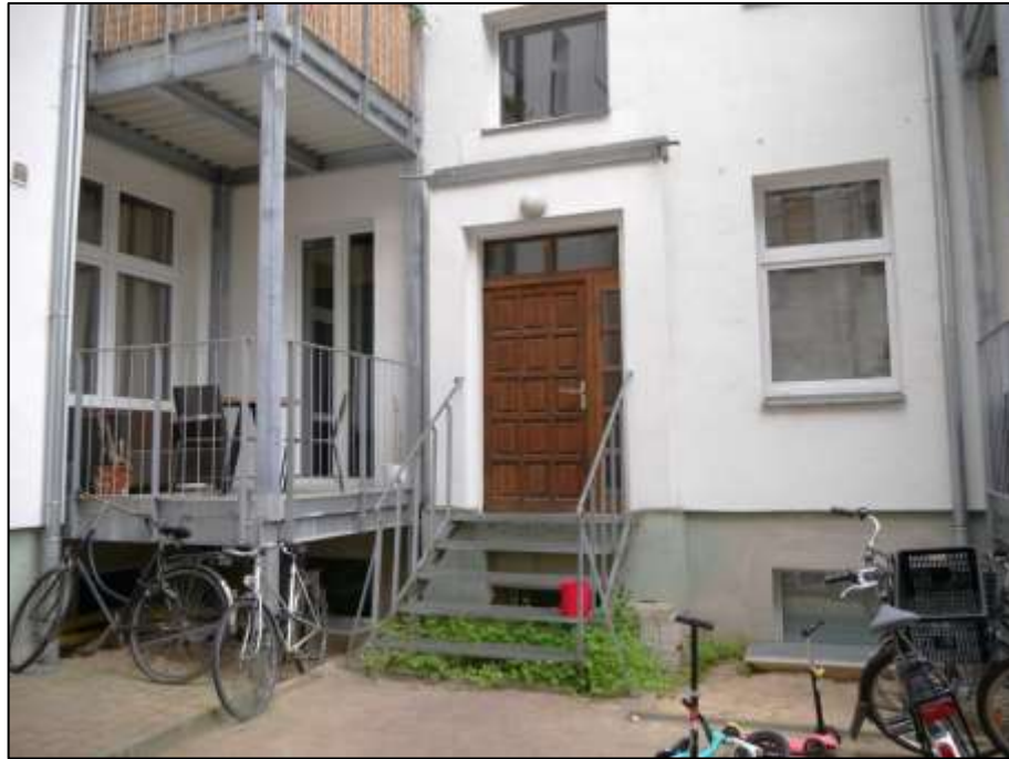
hofseitigen Fronten des linken Seitenflügels links im Bild und des hieran rechts anbindenden Quergebäudes im Bereich des Hochparterres und des darunter belegenen Souterrains sowie Differenzterasse zum Hochparterre mit anbindendem Quergebäudetreppenhaus
