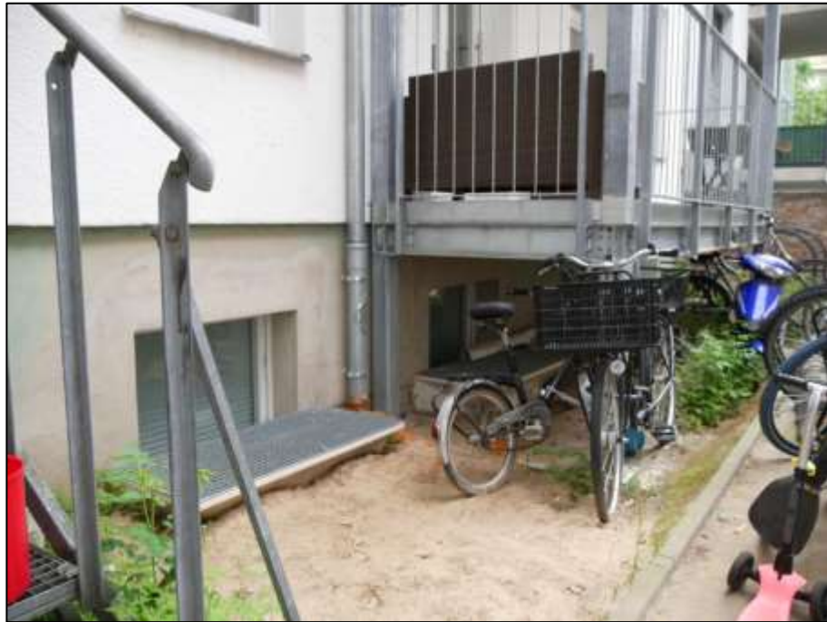
Weitgehend über Terrain aufgehende Souterrainfenster des unter dem Hochparterre im Quergebäude belegenen Souterrains
