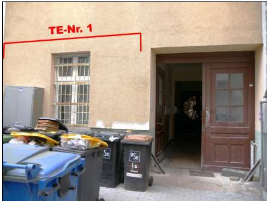
hofseitige Front des Vorderhauses im Bereich der Doppelflügeltoranlage zur Gebäudedurchfahrt mit links im Bild angrenzendem Teileigentums Nr. 1
