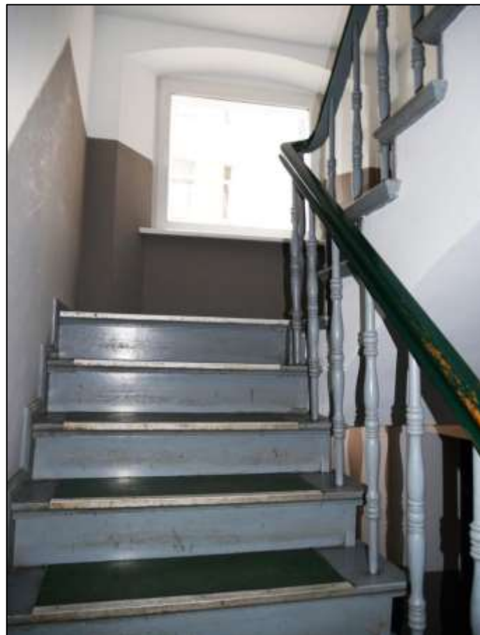
Treppenhaus- aufgang im Quergebäude mit Fenster über der Zwi- schenge- schosspodest- fläche
