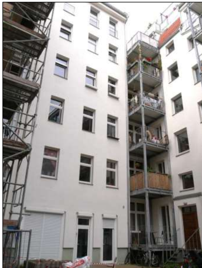
Blick aus dem Bereich der Gebäudedurchfahrt des Vorderhauses auf die hofseitigen Fronten des linken Seitenflügels und des rechts im Bild anbindenden Quergebäudes
