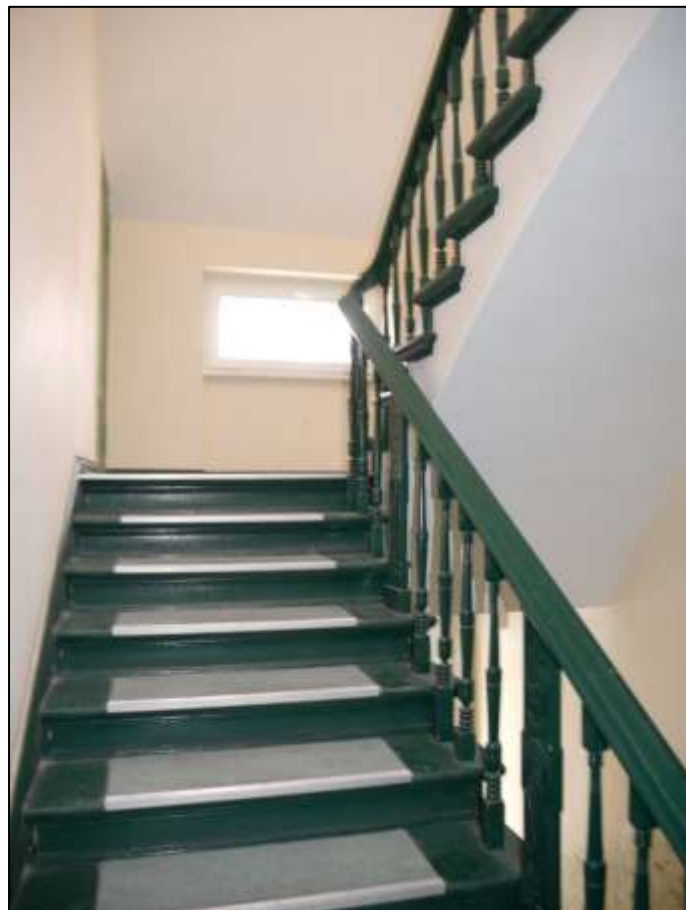
Treppenhaus- aufgang im Vor- derhaus mit Fensterluke in der hofseitigen Auswand über dem letzten Zwischenge- schoss unter dem Treppen- hauskopf
