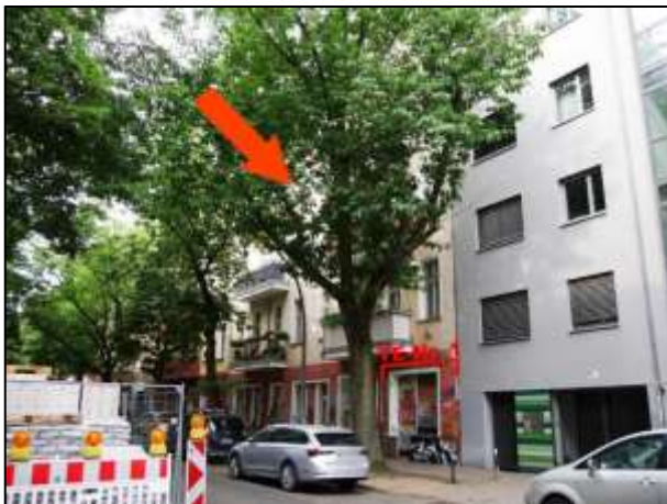
straßenseitige Gebäudefront mit TE-Nr. 1
