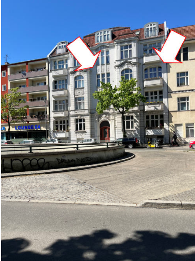
Bundesallee 63 in 12161 Berlin-Friedenau - Wohnung Nr. 8 im 2. Obergeschoss - - Gebäudeansichten -
