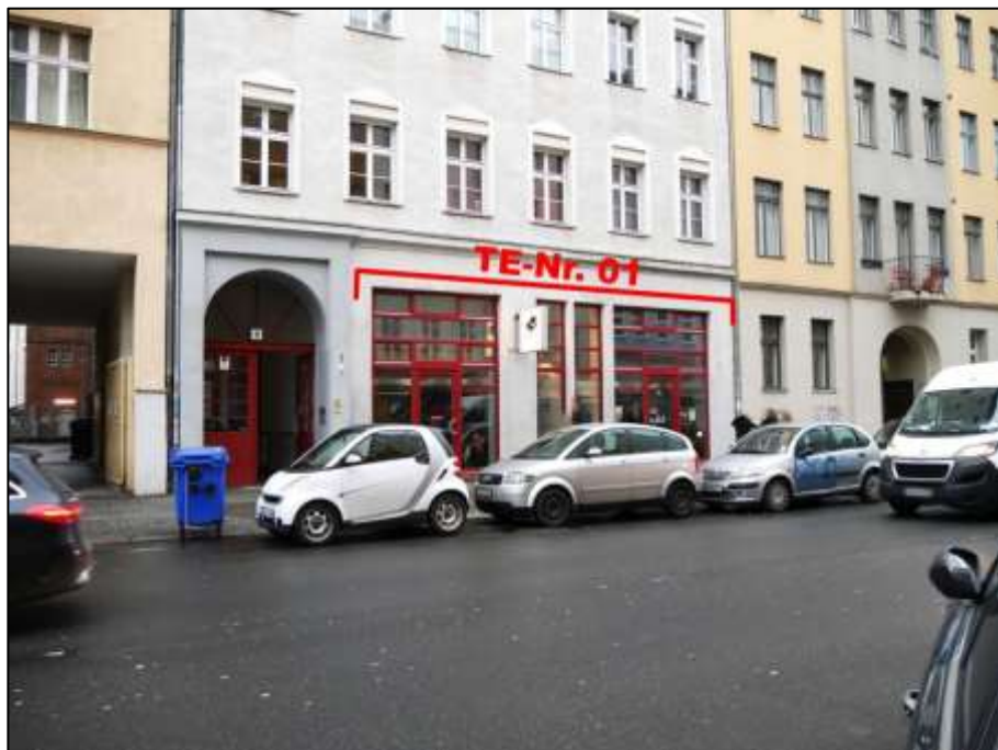
Blick über die Zossener Straße auf die straßenseitige Front des Vorderhauses auf dem Grundstück Zossener Straße 8 im Bereich des Erdgeschosses mit Lage des Teileigentums Nr. 1 als Ladeneinheit und links daneben belegener ehemaliger Gebäudedurchfahrt mit Hauseingangstor
