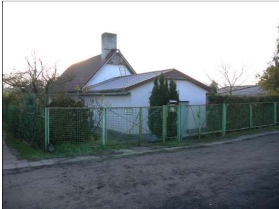
straßenseitige Front des Grundstücks Maronensperlingweg 84 mit aufstehender Massivgarage im Vordergrund und dahinter anbindender Wohnlaube sowie links im Bild vor dem Grundstück abgehender Stichweg des Maronensperlingwegs
