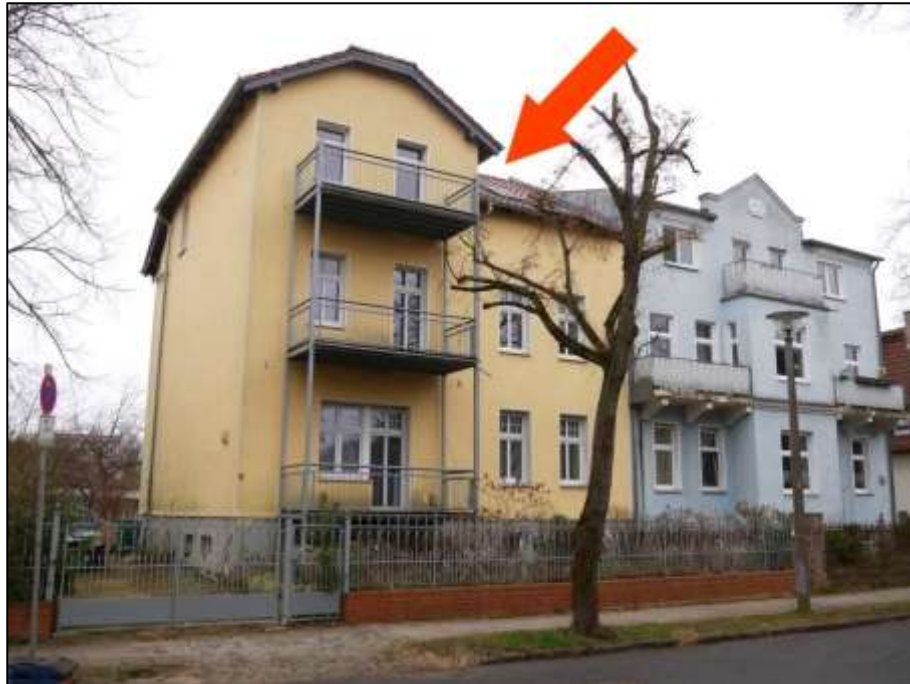
Blick über den Röbellweg nach Süden mit auf dem Grundstück Röbellweg 72 aufstehendem Mehrfamilienhaus (Pfeil) als einseitige Grenzbebauung zu dem auf dem rechts angrenzenden Nachbargrundstück Röbellweg 70 aufstehenden Mehrfamilienhaus
