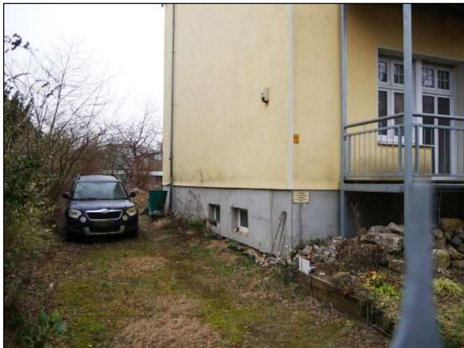
Blick über die Einfriedung in den linken Bauwich vor der freien Giebelseite des Wohngebäudes mit im linken Bauwich belegenen ungedecktem PKW-Stellplatz
