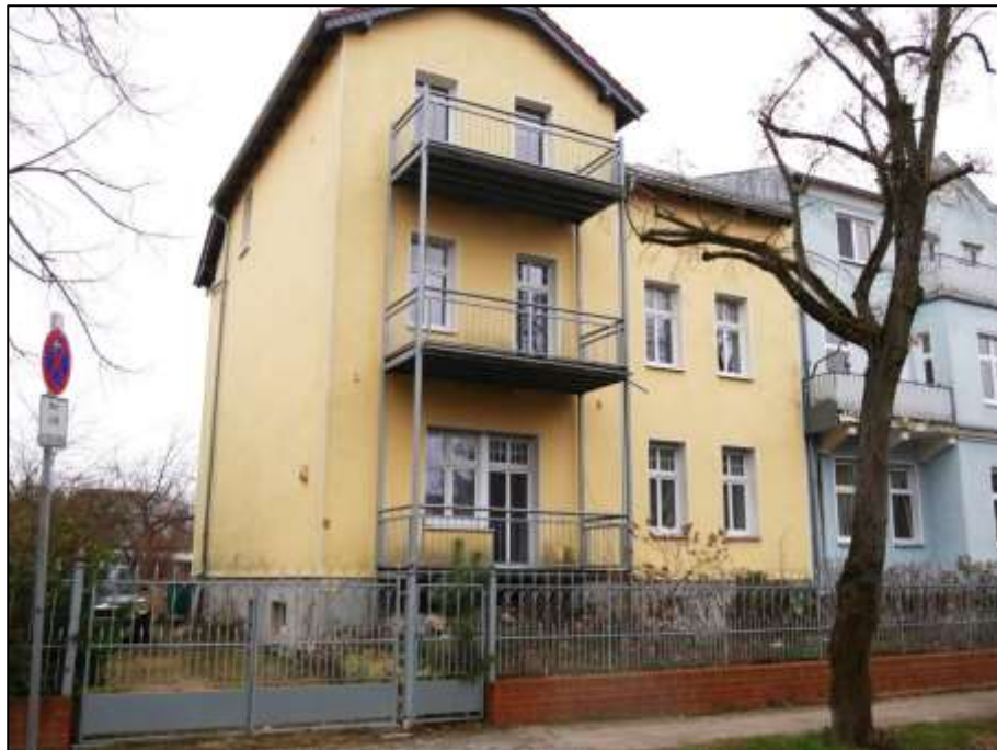
straßenseitige Front des Grundstücks Röbellweg 72 und auf dem Grundstück aufstehendes Mehrfamilienhaus als einseitige Grenzbebauung mit straßenseitiger Gebäudefront und freier Giebelseite
