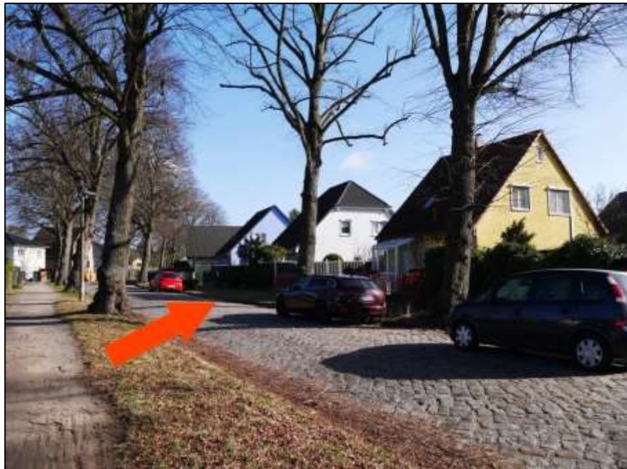
Blick über die Flaischlenstraße nach Nord-Osten mit Lage des auf dem Grundstück Flaischlenstr. 8 aufstehenden Einfamilienhauses auf der nord-östlichen bzw. im Bild rechten Straßenseite (Pfeil)
