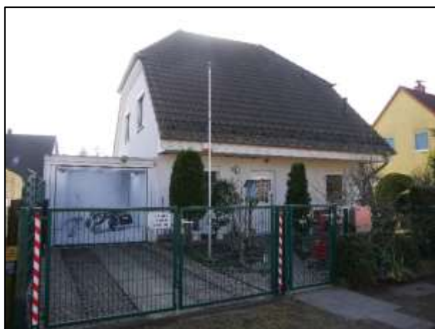
Hauseingangsfront u. linker Giebel + Garage
