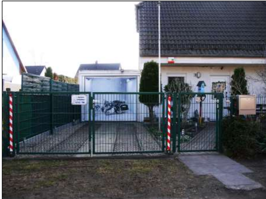
straßenseitige Front des Grundstücks Fleischlenstr. 8 mit unbefestigter Grundstücksauffahrt im Straßenraum und anbindender befestigter Zufahrt auf dem Grundstück selbst mit im linken Bauwich des Einfamilienhauses unmittelbar vor der nord-östlichen Giebelseite anbindender Grenzgarage
