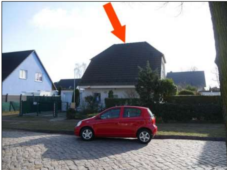
Blick über die Fleischlenstraße nach Osten mit straßenseitiger Front des Grundstücks Fleischlenstr. 8 und dem auf dem Grundstück aufstehenden Einfamilienhauses mit Krüppelwalmdach und Garage im linken Bauwich
