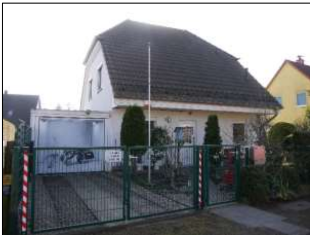
Hauseingangsfront u. linker Giebel + Garage
