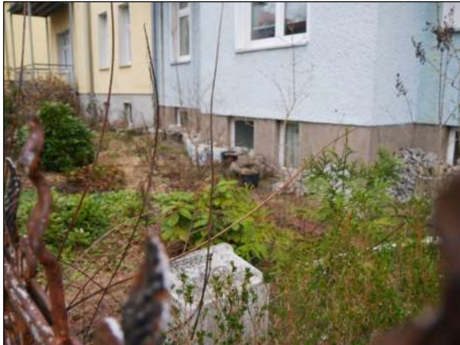
Blick über die Einfriedung des hier betroffenen Grundstücks auf die straßenseitige Front des auf dem Grundstück Röbbellweg 70 aufstehenden Mehrfamilienhauses im Bereich des Kellergeschosses mit über Terrain aufgehenden Fenstern
