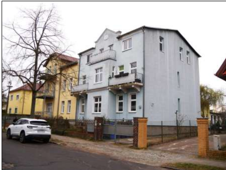
straßenseitige Front des Grundstücks Röbellweg 70 und auf dem Grundstück aufstehendes Mehrfamilienhaus als einseitige Grenzbebauung mit straßenseitiger Gebäudefront und freier Giebelseite
