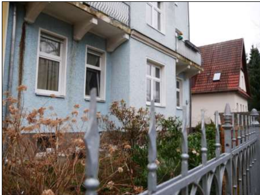
Blick über die Einfriedung des links angrenzenden Nachbargrundstücks auf die straßenseitige Front des auf dem Grundstück Röbbellweg 70 aufstehenden Mehrfamilienhauses im Bereich des Hochparterres
