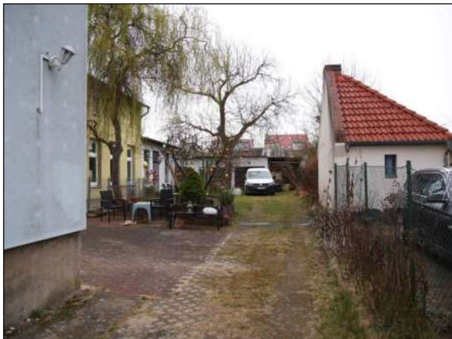
Blick über die Einfriedung in den rechten Bauwich vor der freien Giebelseite des Wohngebäudes mit im Hintergrund belegener Garagenzeile sowie Remise links im Bild und dahinter anbindendem Massivschuppen
