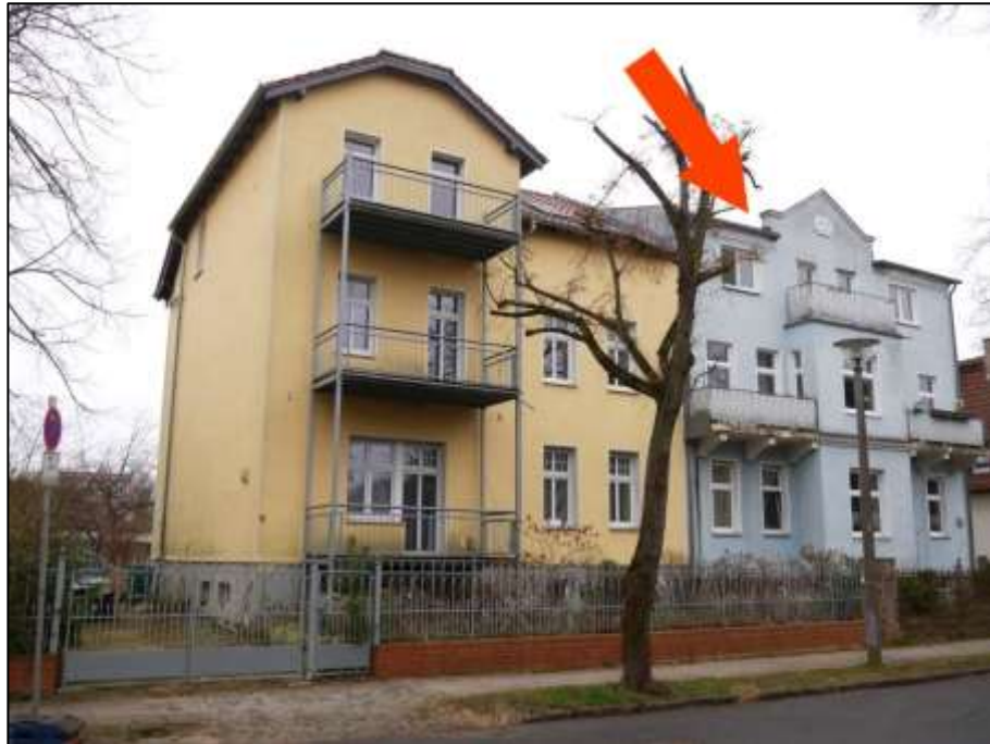
Blick über den Röbellweg nach Süden mit auf dem Grundstück Röbellweg 70 aufstehendem Mehrfamilienhaus (Pfeil) als einseitige Grenzbebauung zu dem auf dem links angrenzenden Nachbargrundstück Röbellweg 72 aufstehenden Mehrfamilienhaus
