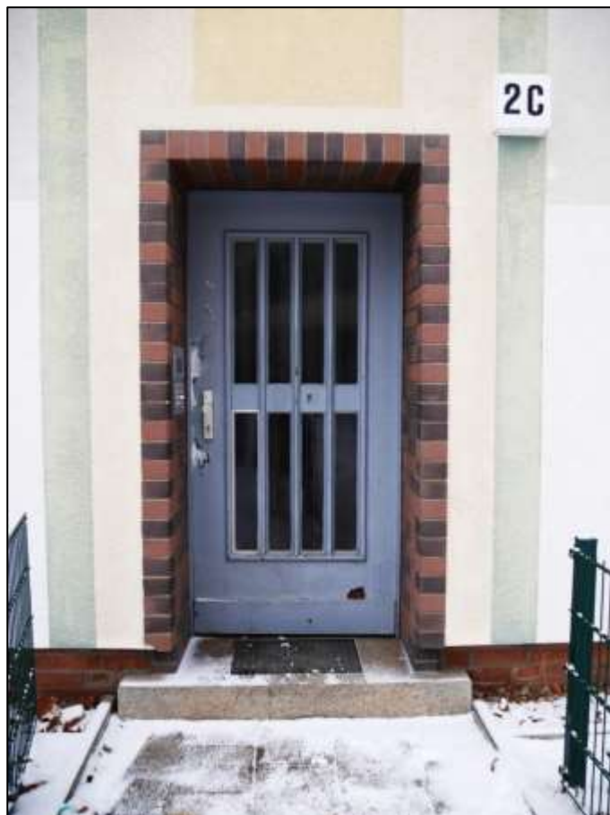
Haueingangstür zum Treppen- haus des Ge- bäudeteils Hauptstr. 2C
