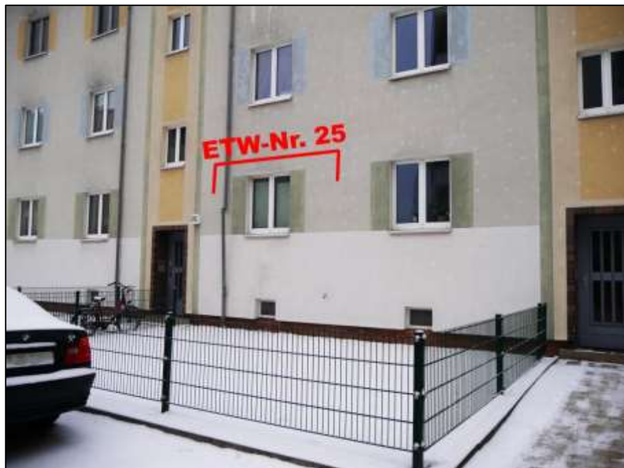
Blick aus der Anrainerstraße auf die Erdgeschosszone mit Lage des Wohnungseigentum Nr. 25 im Hochparterre des Gebäudeteils Hauptstr. 2C
