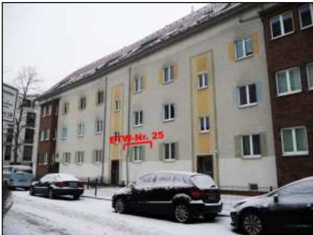
Gebäude Hauptstr. 2C mit ETW-Nr. 25 im EG
