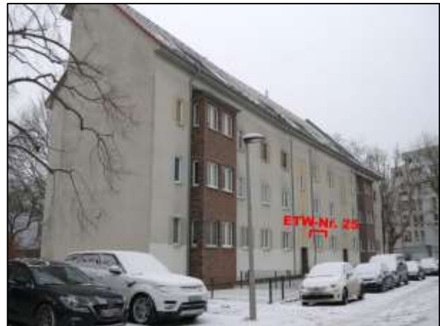
zur Anrainerstraße orientierte Gebäudefront
