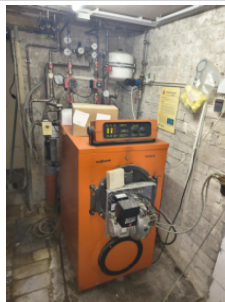
Bild 12-15 o Ansichten vom Kellergeschoss: Ölheizkessel, Tanklager und E-Verteilung (augenscheinlich mit Kraftstromanschluss)
