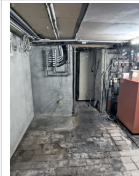
Bild 12-15 o Ansichten vom Kellergeschoss: Ölheizkessel, Tanklager und E-Verteilung (augenscheinlich mit Kraftstromanschluss)
