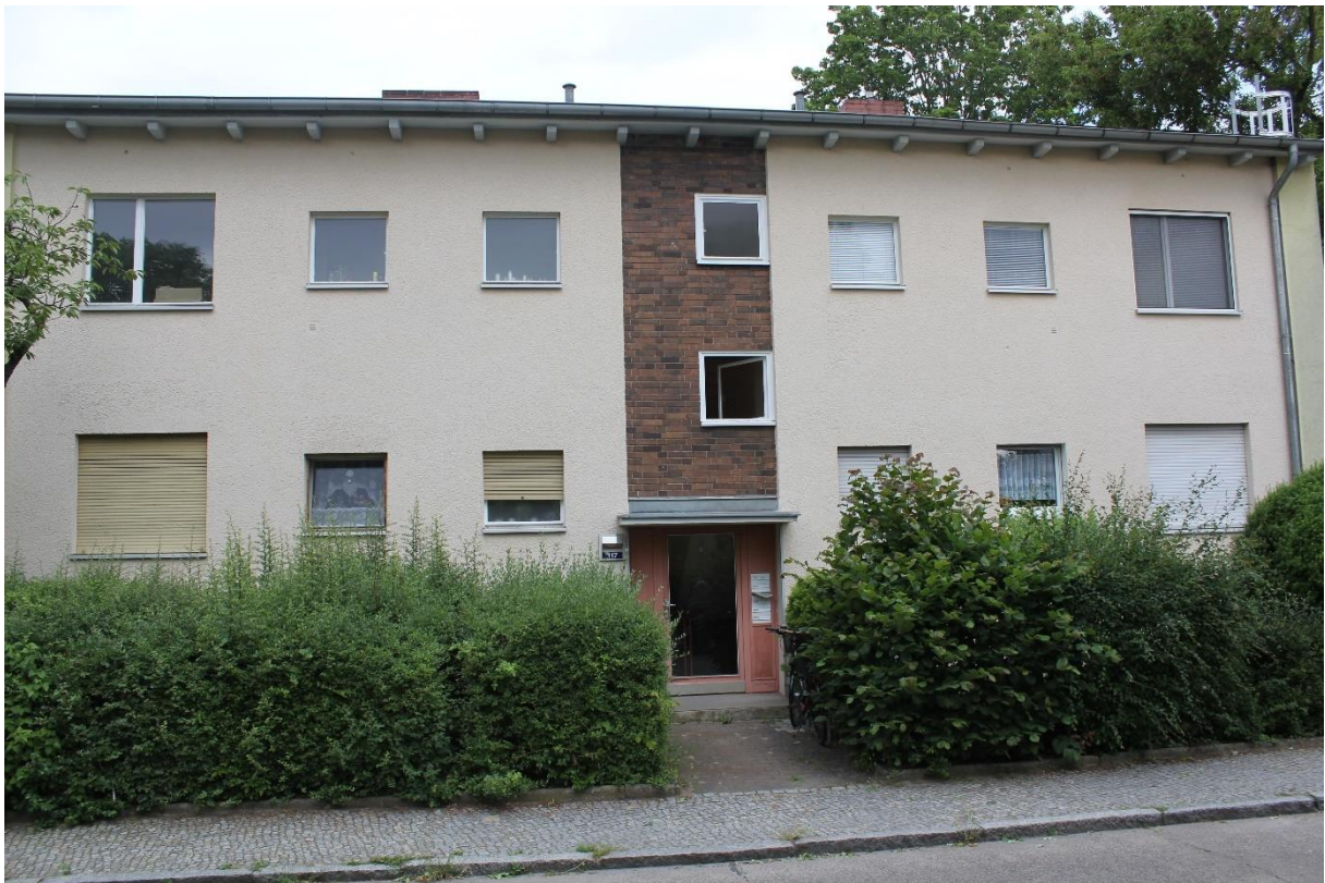
Wohngebäude Wichurastraße 117, straßenseitige Perspektive
