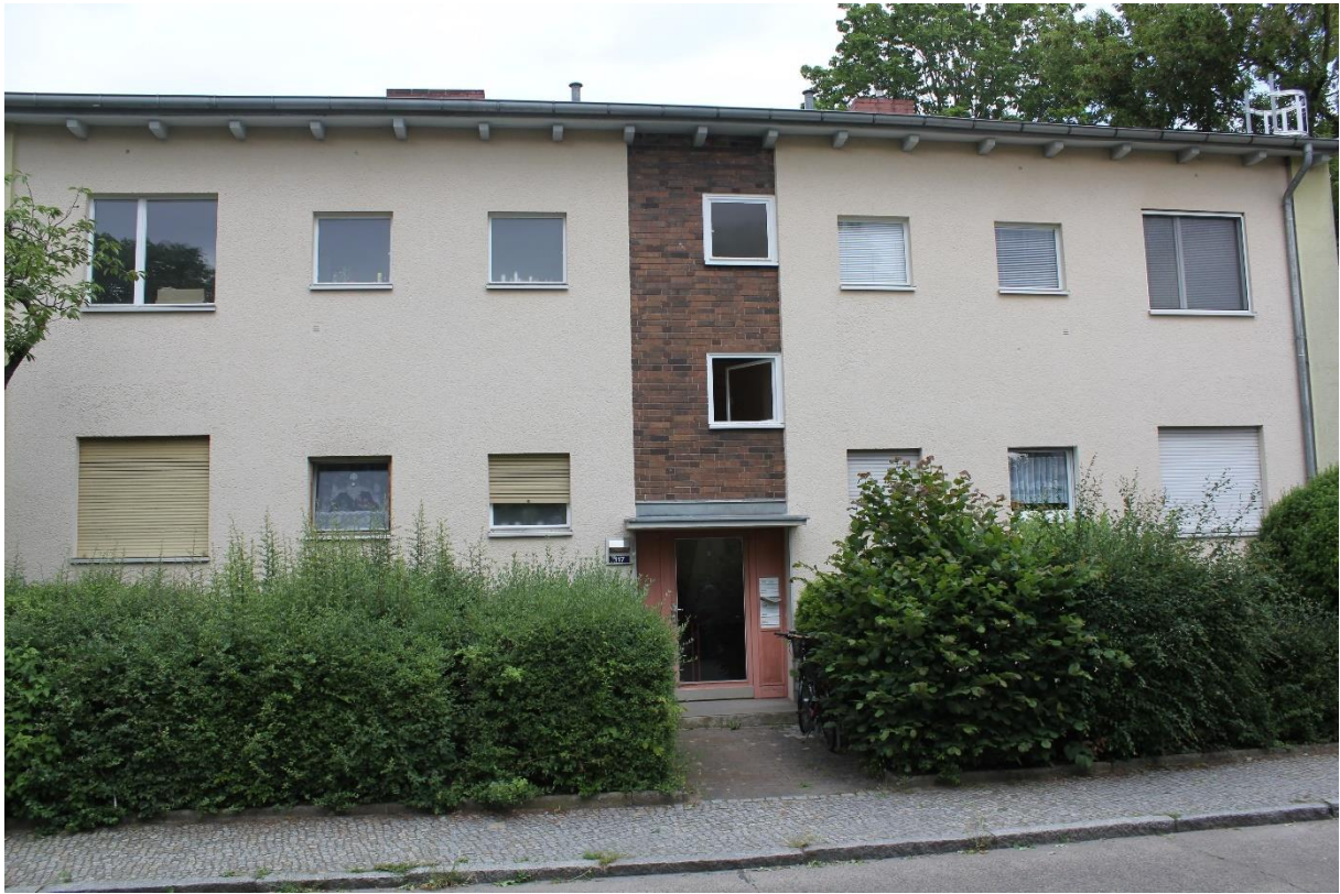
Wohngebäude Wichurastraße 117, straßenseitige Perspektive
