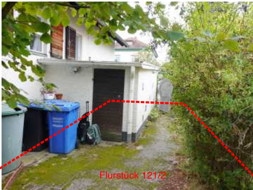
Flurstück 121/2 (Verkehrsfläche), Blick Richtung Straße, Überbau durch die Garage
