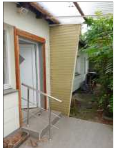
Südansicht mit Hauseingang
