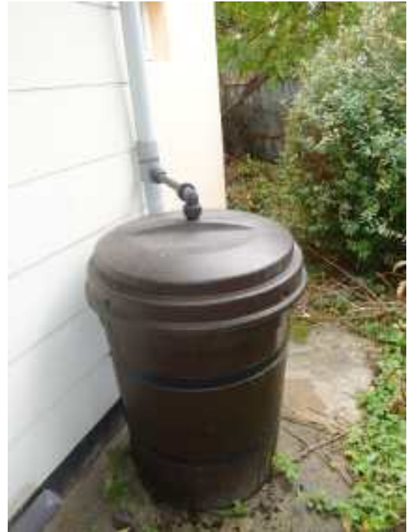
Südfassade mit Sammelfaß für Regenwasser
