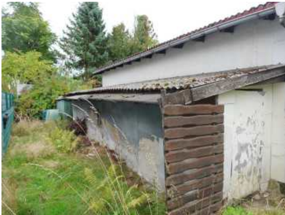
Nordansicht mit Schuppenanbau
