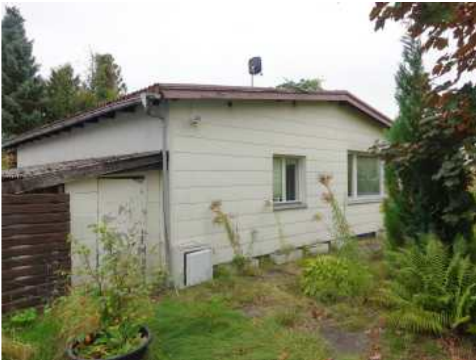
Westansicht des Bungalows auf dem Grundstück
