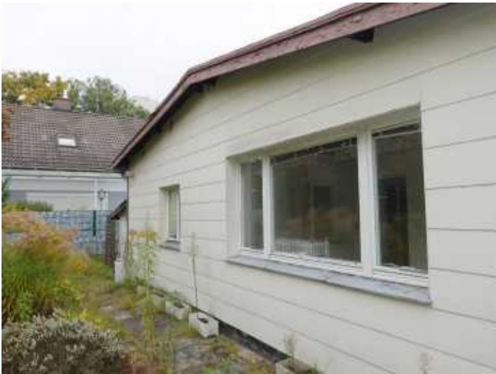
Westansicht des Bungalows auf dem Grundstück
