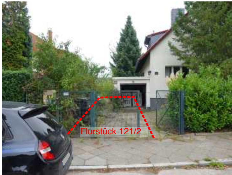
Flurstück 121/2 (Verkehrsfläche), Blick Richtung Osten auf das Grundstück. Die Garage überbaut das Flurstück und verhindert damit die Zufahrt zum Bewertungsgrundstück. Sie gilt im Rahmen der Bewertung als Abbruch.
