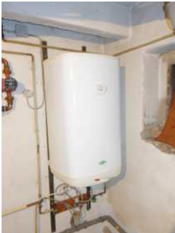
E-Warmwasserspeicher
