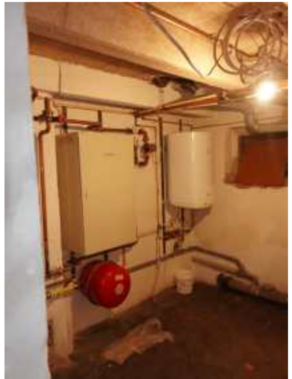
E-Warmwasserspeicher
