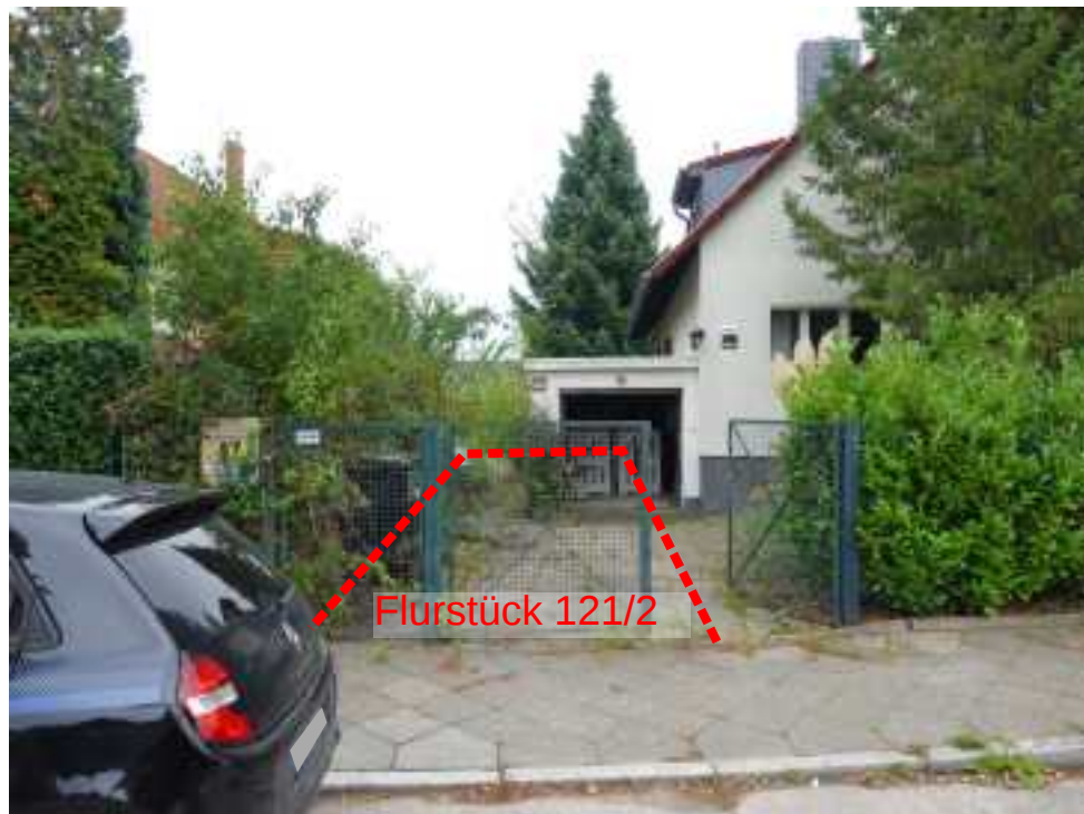
Flurstück 121/2 (Verkehrsfläche), Blick Richtung Osten auf das Grundstück. Die Garage überbaut das Flurstück und verhindert damit die Zufahrt zum hinteren Grundstück. Sie gilt im Rahmen der Bewertung als Abbruch.
