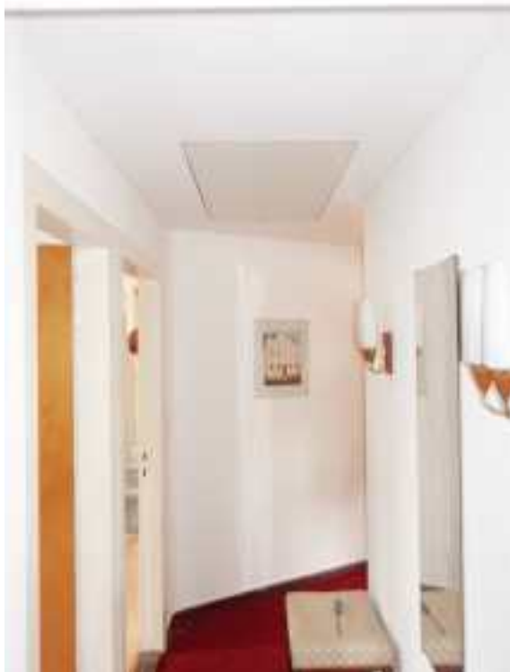
Flur mit Auszugstreppe für den Spitzboden
