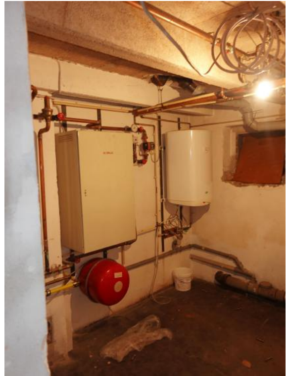
E-Warmwasserspeicher
