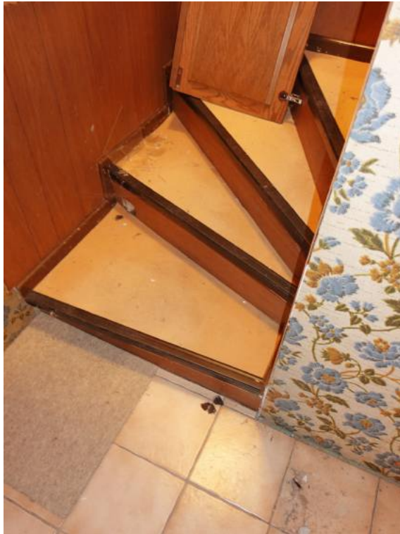
Kellergeschoss, Treppe vo, KG zum EG
