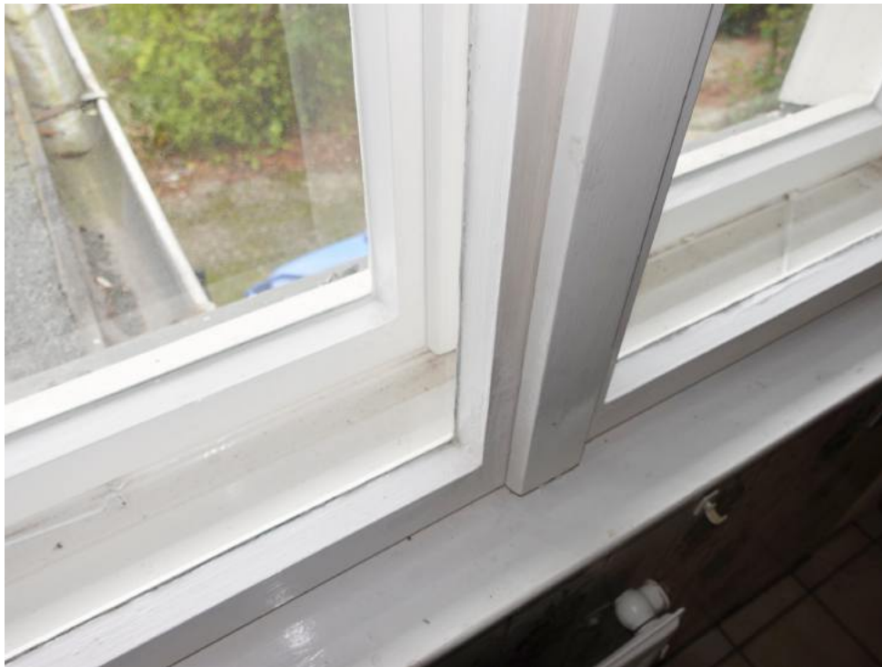
Detail Holzkasten-Doppelfenster
