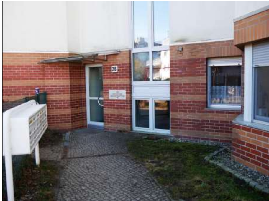
Treppenzugang an der zum Blockinnenbereich orientierten Rückseite des auf dem Grundstück Waldemarstr. 36 aufstehenden Mehrfamilien-Wohngebäudes mit KITA im Erd- und 1. Obergeschoss
