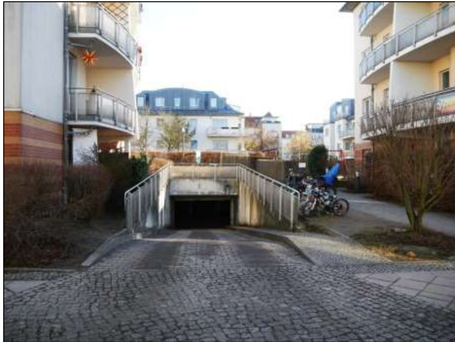
Tiefgaragen-Ein- und Ausfahrt für alle an den Wohnblock anliegenden Grundstücke auf dem Grundstück Waldemarstraße 36 mit Gehwegüberfahrt im Vordergrund
