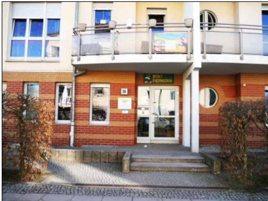
von der Waldemarstraße aus zugänglicher Eingang der in dem auf dem hier betroffenen Grundstück Waldemarstr. 36 aufstehenden Gebäude im Erd- und 1. Obergeschoss belegenen KITA
