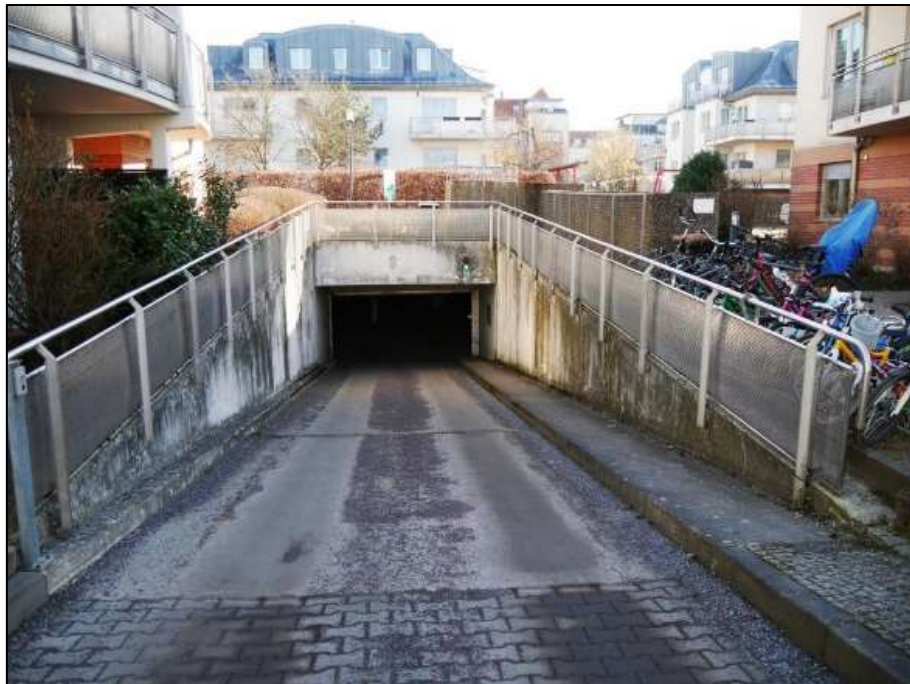
Tiefgaragen-Ein- und Ausfahrt für alle an den Wohnblock anliegenden Grundstücke auf dem Grundstück Waldemarstraße 36
