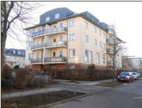
Wohngebäude a.d. Grdst. Waldemarstr. 36
