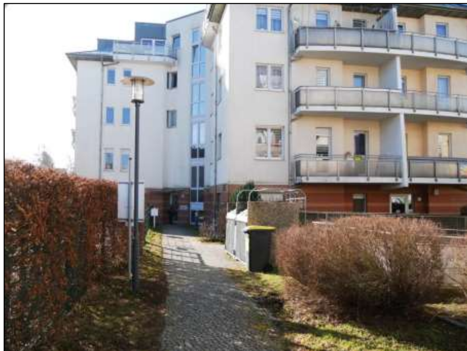
Blick von der öffentliche Durchwegung auf dem hier betroffenen Grundstück Waldemarstr. 36 mit aufstehendem Mehrfamilien-Wohngebäude nebst KITA im Erd- und 1. Obergeschoss und großflächiger Spielplatzanlage oberhalb der unterirdischen Tiefgarage links im Bild
