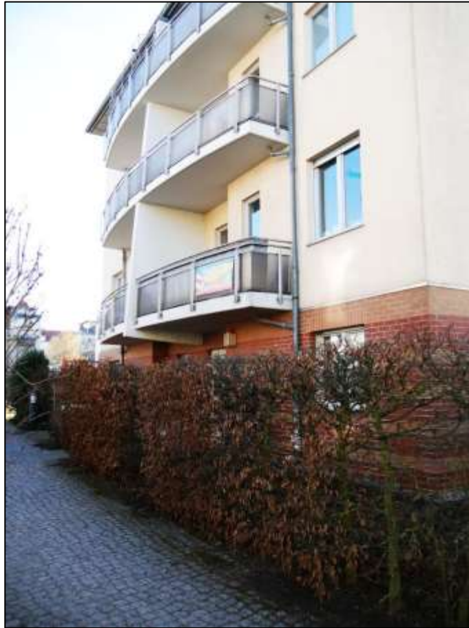
nördliche Giebel- seite des auf dem Grundstück Wal- demarstr. 36 auf- stehenden Mehr- familien-Wohnge- bäudes mit KITA im Erd- und 1. Obergeschoss mit davor belegener Hauszuwegung
