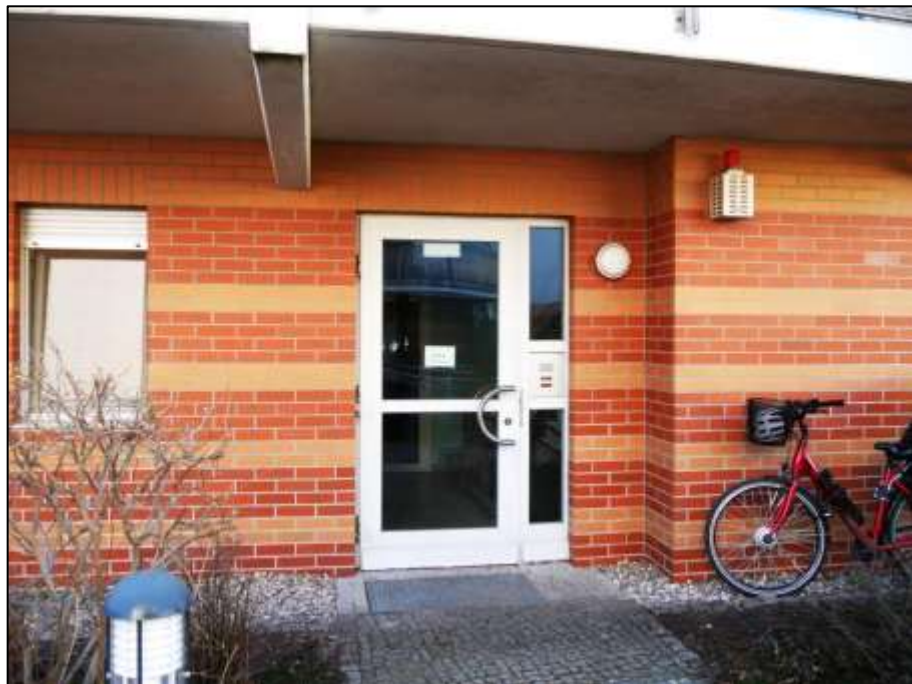
Nebeneingang zur KITA des auf dem Grundstück Waldemarstr. 36 aufstehenden Mehrfamilien-Wohngebäudes mit KITA im Erd- und 1. Obergeschoss in der nördlichen Giebelseite des Gebäudes
