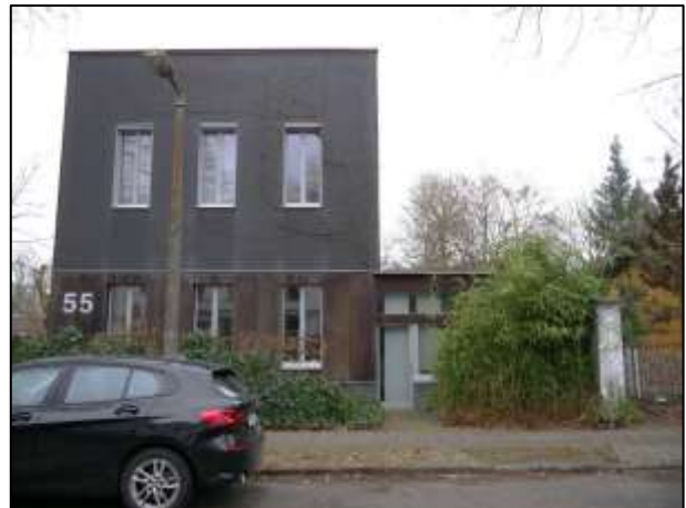
straßenseitige Front des Einfamilienhauses
