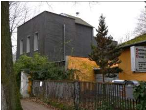
EFH auf dem Grdst. Heegermühler Weg 55
