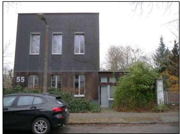
straßenseitige Front des Einfamilienhauses
