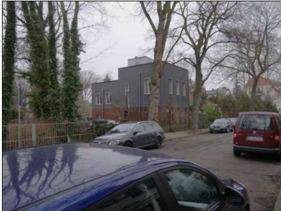
Blick über den Heegermühler Weg nach Nord-Westen auf das Grundstück Heegermühler Weg 55 mit aufstehendem Einfamilienhaus mit nach Süden orientierter Hauseingangsfrent und straßenseitiger Gebäudefront sowie dem über dem gestuften Flachdach aufgehenden Treppenhauskopf
