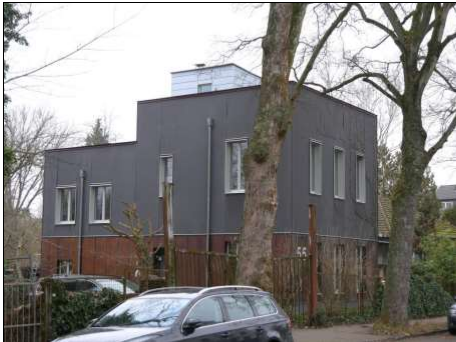
straßenseitige Grundstücksfront mit auf dem Grundstück Heegermühler Weg 55 aufstehendem Einfamilienhaus mit nach Süden orientierter Hauseingangsfront und straßenseitiger Gebäudefront sowie über dem gestuften Flachdach aufgehendem Treppenhauskopf
