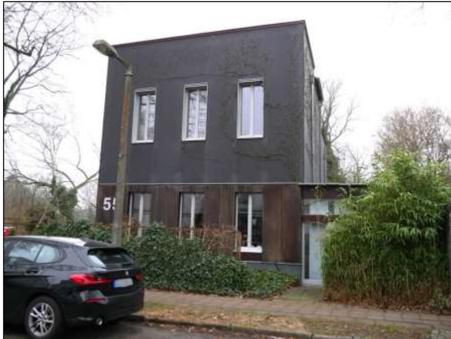
straßenseitige Gebäudefront des auf dem Grundstück Heegermühler Weg 55 aufstehenden Einfamilienhauses
