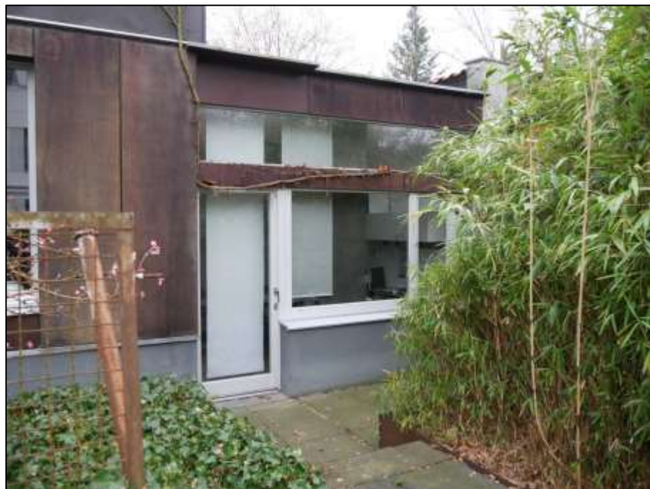
Blick über die straßenseitige Einfriedung des Grundstücks Heegermühler Weg 55 auf die straßenseitige Gebäudefront im Bereich des Erdgeschosses mit straßenseitigem Hauseingang zum Arbeitszimmer (Atelier) im 1-geschossigen Seitentrakt des Einfamilienhauses
