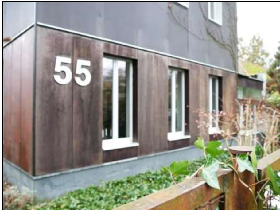
Blick über die straßenseitige Einfriedung des Grundstücks Heegermühler Weg 55 im Bereich der ursprünglichen Pforte der Hauszuwegung auf die straßenseitige Gebäudefront im Bereich des Erdgeschosses
