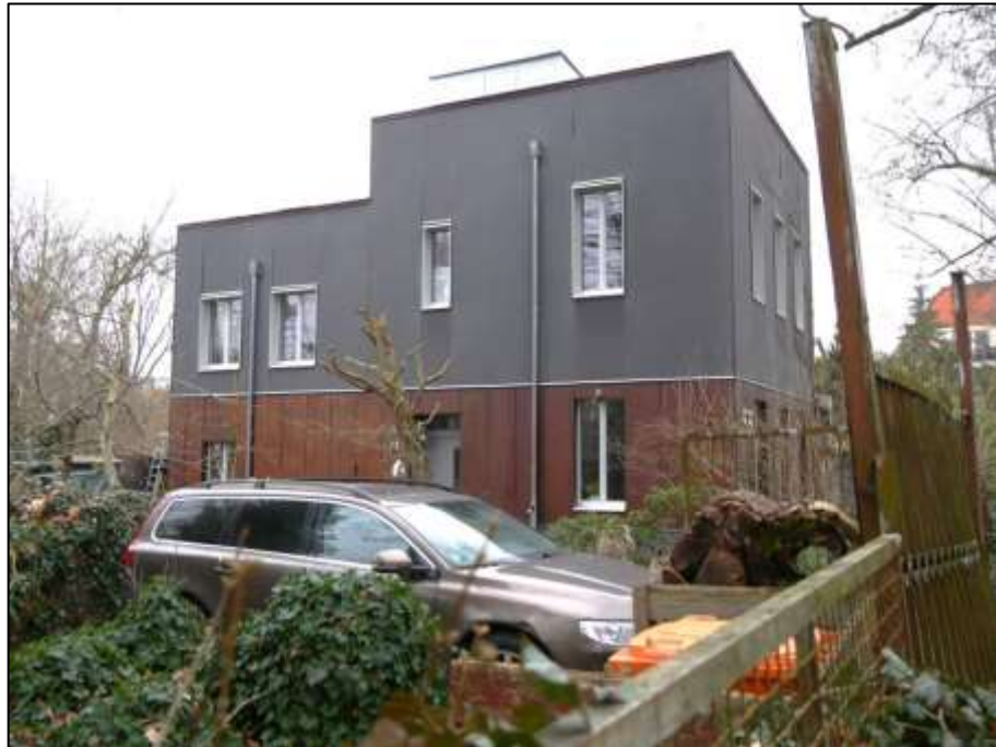
Blick über die straßenseitige Einfriedung und den auf dem Grundstück belegenen PKW-Stellplatz auf das auf dem Grundstück Heegermühler Weg 55 aufstehende Einfamilienhaus mit nach Süden orientierter Hauseingangsfront und straßenseitiger Gebäudefront
