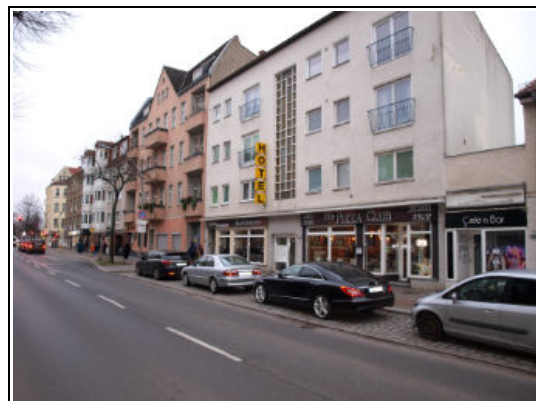
Seegefelder Straße in Richtung Osten (Bahnhof Spandau), überwiegend geschlossene 4-geschossige Bebauung
