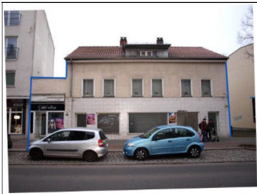
Straßenansicht aus Richtung Norden
