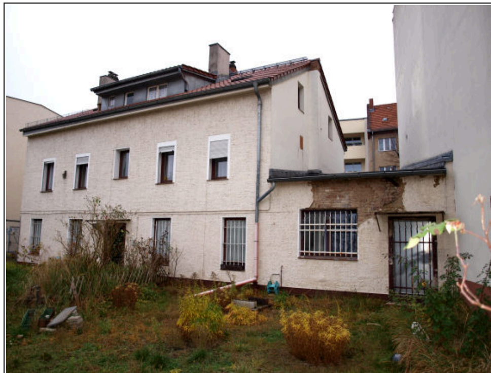
Abbildung 8: rückseitige Ansicht, Zugang rechts zum eingeschossigen Anbau
