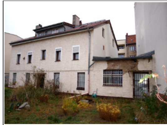
rückseitige Ansicht, Zugang rechts zum eingeschossigen Anbau
