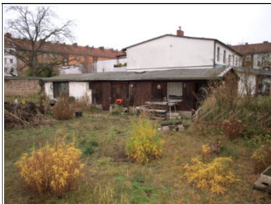
ruinöses Nebengebäude, frühere Nutzung als Sattlerei
