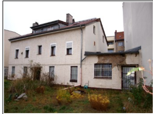
rückseitige Ansicht, Zugang rechts zum eingeschossigen Anbau
