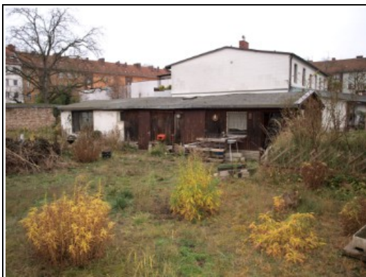
ruinöses Nebengebäude, frühere Nutzung als Sattlerei
