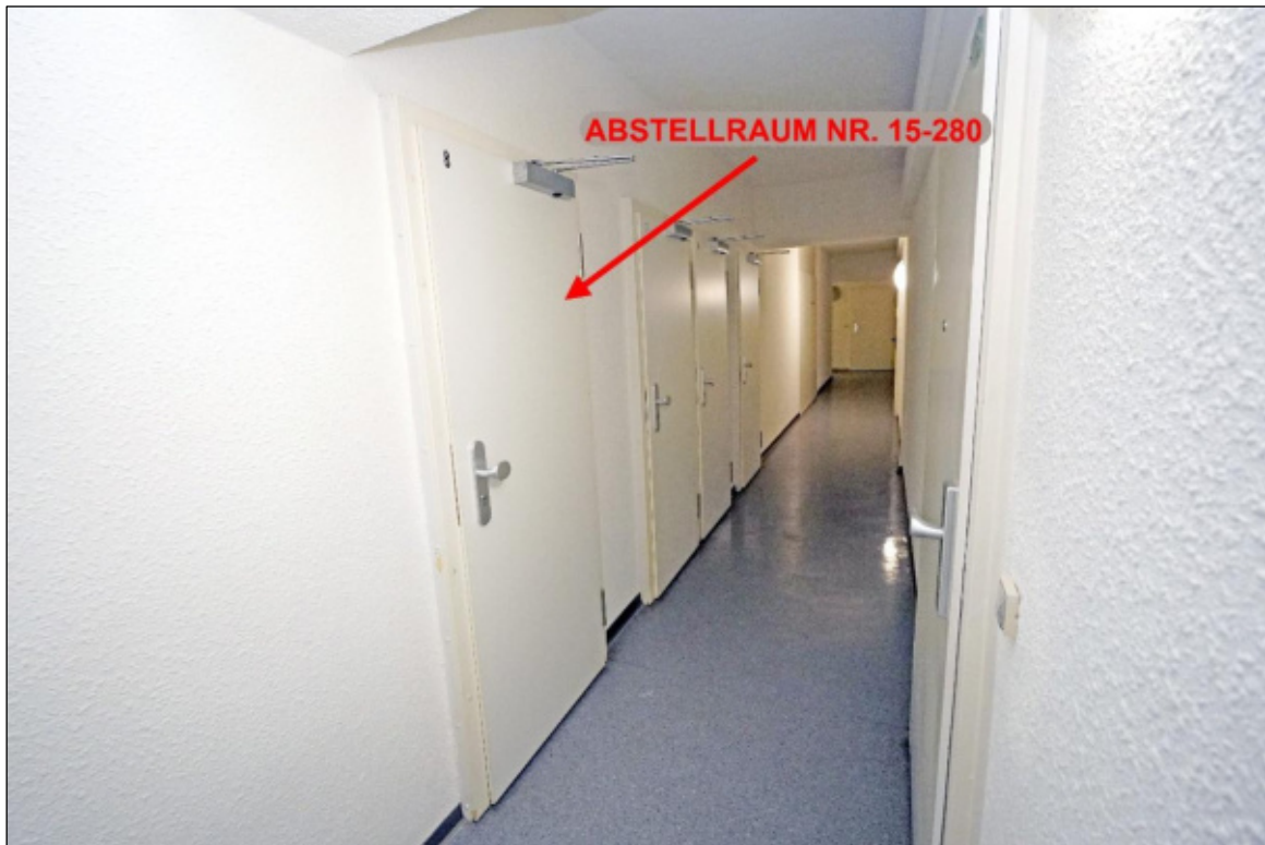
Zugangstür Abstellraum Nr. 15-280
