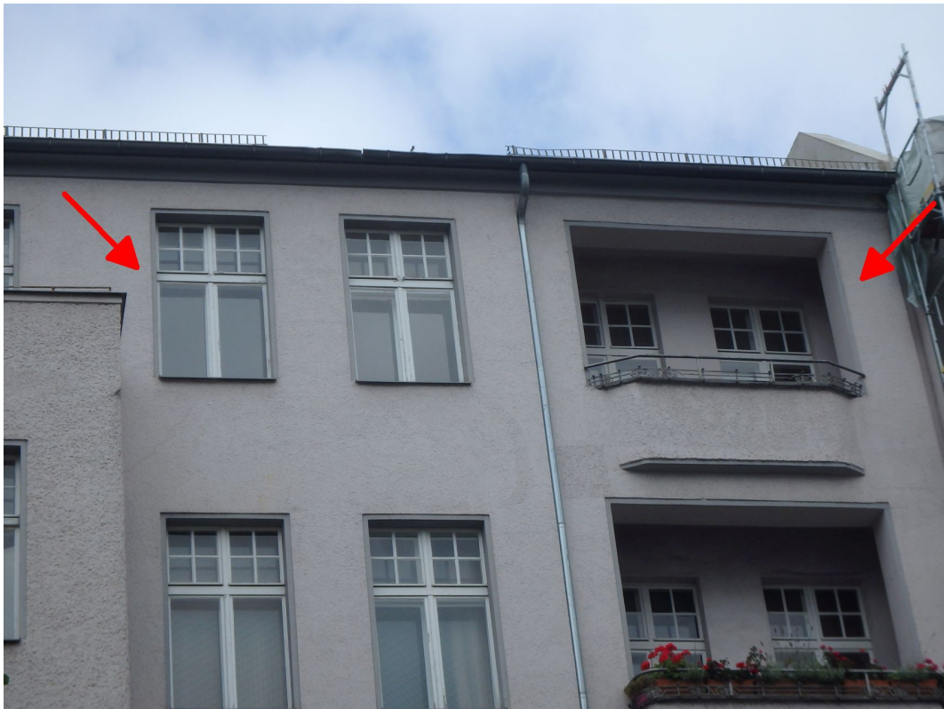
Wohn- und Geschäftshaus sowie Eigentumseinheit Nr. 9 Ostansicht (Straßenansicht)
