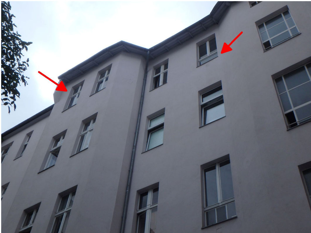
Wohn- und Geschäftshaus (Seitenflügel) sowie Eigentumseinheit Nr. 17 Nordansicht (Hofansicht)
