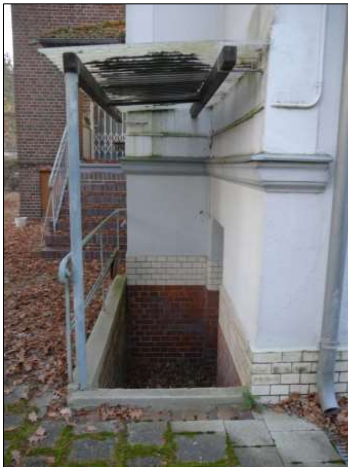
Kelleraußentreppe vor der rückwärtigen Front des auf dem Grundstück aufstehenden Wohngebäudes
