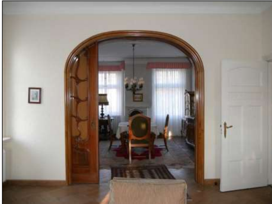
Korbborgendurchgang mit Doppelflügel-Schiebetür in Futtertaschen zwischen dem straßenseitigen und dem gartenseitigen Teil des Wohnzimmers im Obergeschoss mit Blick in den straßenseitigen Raum
