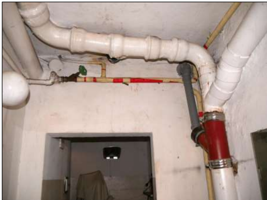
Frisch- und Abwasserinstallationen unter der Decke im Vorraum als Durchgangsraum zur innenliegenden Teeküche als gefangener Raum
