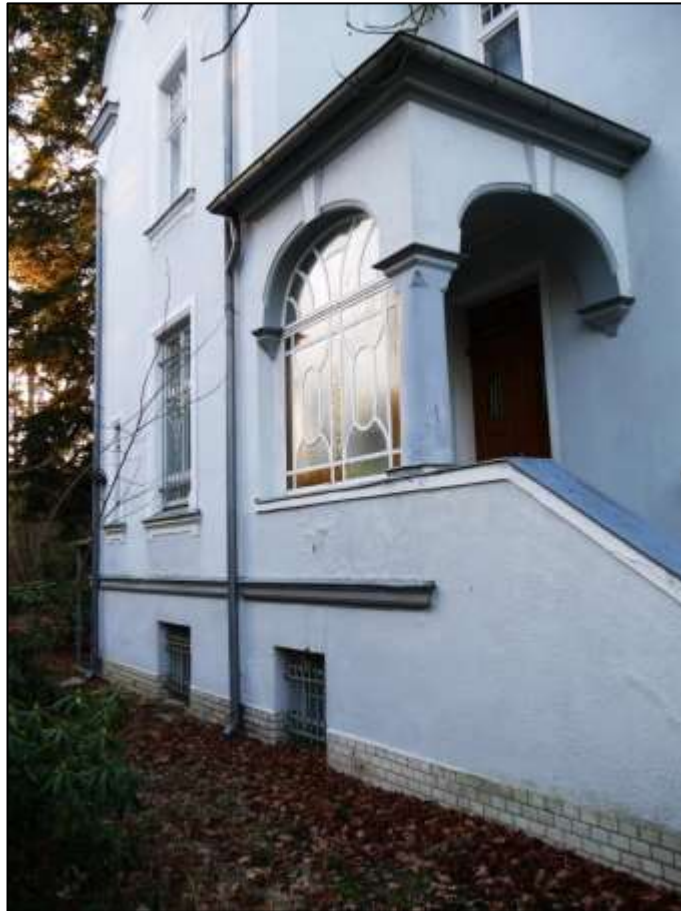
Blick aus dem linken Bauwich auf die nord-östliche Gebäudedefront mit 1-geschossigem Eingangsvorbau
