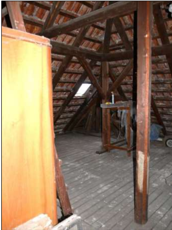
Rohdachboden mit Blick aus dem Vorflur im Dachgeschoss
