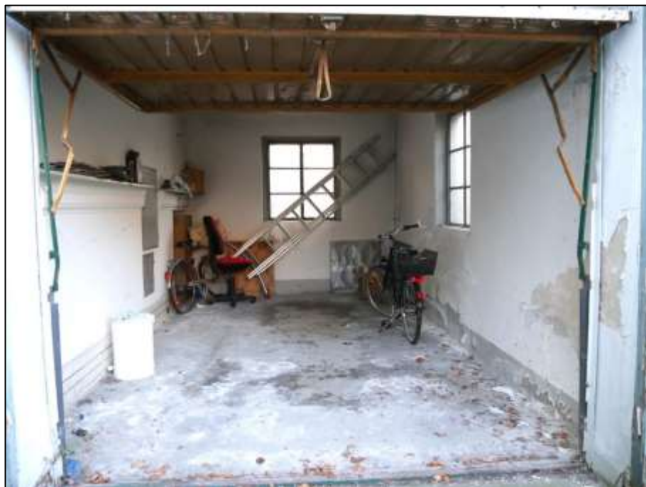
Blick durch die Einfahrt in des im rechten Bauwich belegenen Garagenbaus an das Wohngebäude
