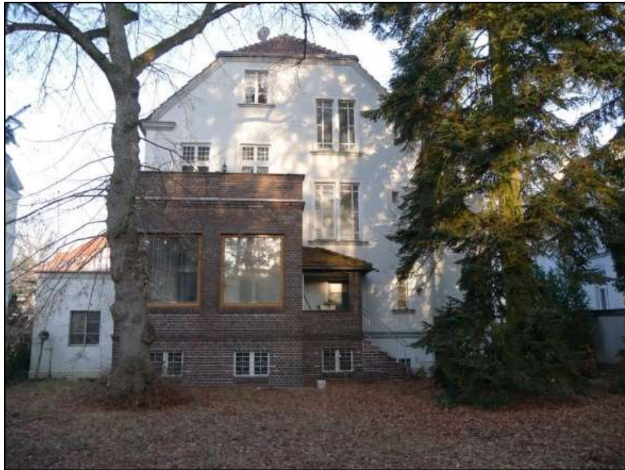
gartenseitige Front des auf dem Grundstück Ringstr. 68 aufstehenden Einfamilienwohnhauses als großzügige Villa und Denkmal mit unterkellertem Wintergarten- bzw. Veranda-Vorbau nebst Außentreppe mit gedeckter Podestfläche sowie Garagen-Anbau im rechten Bauwich (links im Bild)
