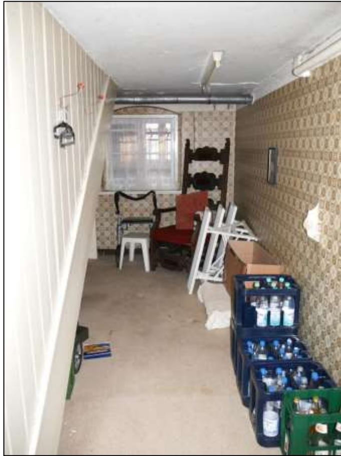
Flur im Keller- geschoss neben dem Treppenaufgang zum Hochparterre mit an der gartenseitigen Gebäudefront verbautem Fenster unterhalb der Außentreppe zum Wintergarten- bzw. Veranda-Vorbau
