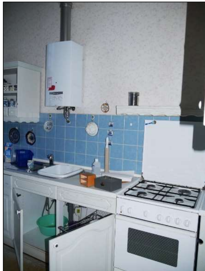
Küche im Hochparterre vor dem Treppenaufgang in das Obergeschoss Gas-herd sowie Spüle nebst Gas-Durchlauferhitzer zur Warmwasserbereitung
