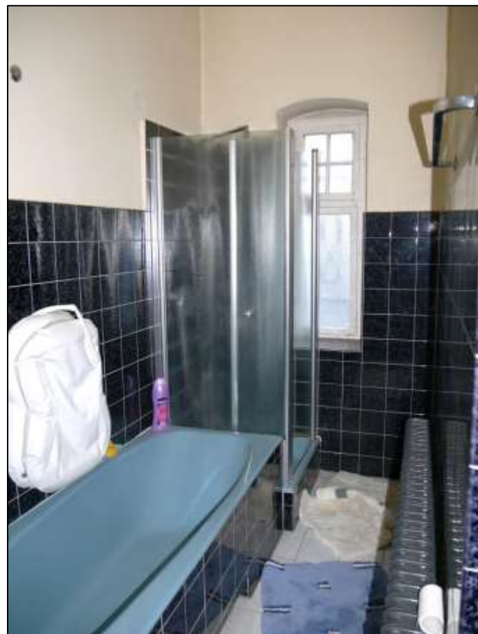
aus dem Flur vor dem eingehausten Kellertreppenabgang zugängliches Badezimmer im Hochparterre vor der Gebäuderückseite
