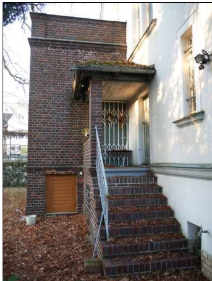
unterkellertes sogen. Winter- gartenvorbau (Veranda) mit Zugang u.a. über eine Au- ßentreppe vor der rückwärti- gen Front des Wohngebäu- destamms so- wie Nebenein- gang von der gedeckten Po- destfläche aus in den Flur des Hochparterres
