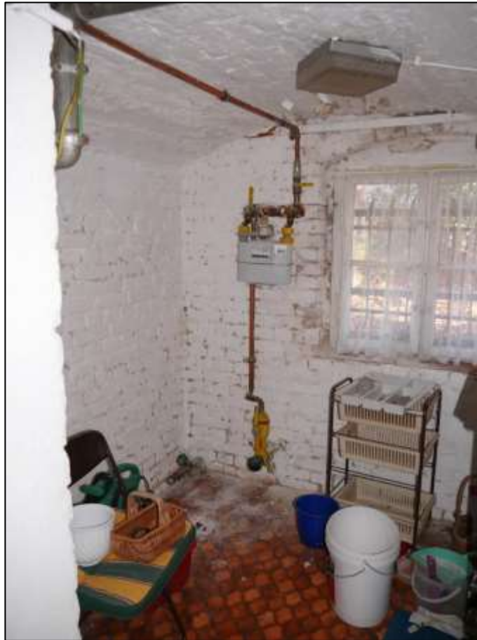
Hausanschlussraum im Kellergeschoss unterhalb des gedeckten Hauseingangsbereichs mit Orientierung des Fensters zum linken Bauwuch
