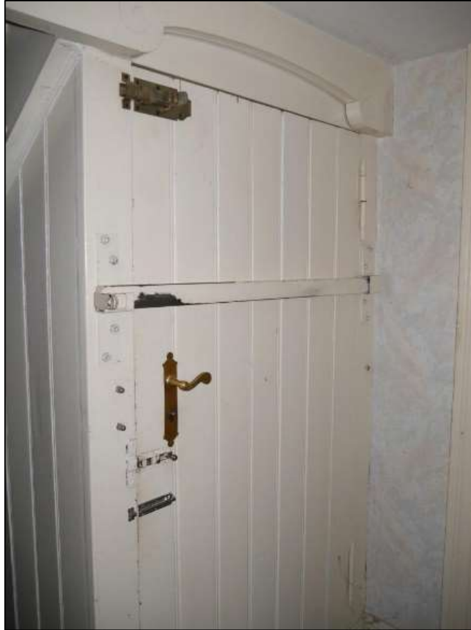
Sperrtür im Flur des im Hoch- parterre einge- hausten Keller- treppenab- gangs
