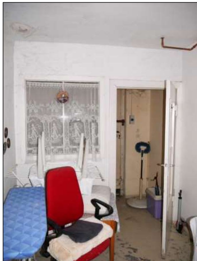
ehemalige Waschküche vor der zum lin- ken Bauwich orientierte Ge- bäudefront im Kellergeschoss mit Innenfen- ster zu einem Windfangvor- raum anbinden- der Kellertür zur Außentrep- pe vor der Ge- bäuderückseite
