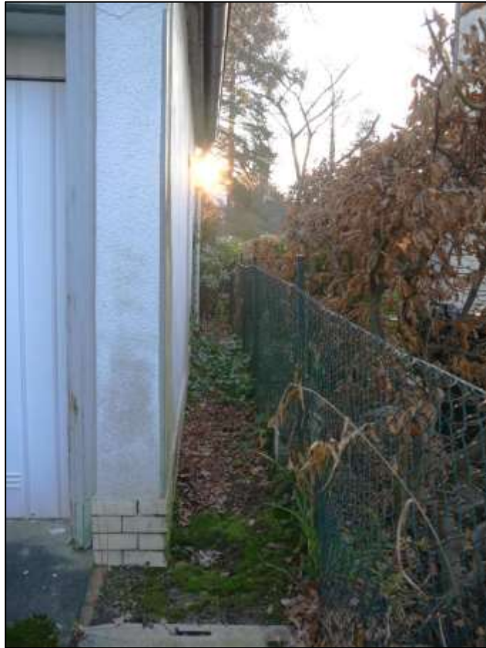
Grenzabstand der im rechten Bauwich errichteten Garage mit Durchwegung zum rückwärtigen Garten vor der Grundstückseinfriedung zum rechten Nachbargrundstück
