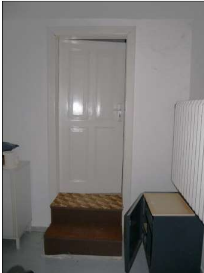
Zugang aus dem straßen- seitigen Büro- raum im Keller- geschoss über ein Differenz- treppe mit 2 Steigungen zu dem in der nord-westlichen Gebäudeecke belegenen Hob- by- bzw. Billard- raum
