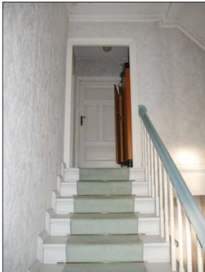
Blick von dem Zwischengeschosspodest über den Treppenlauf in das Dachgeschoss des Gebäudes mit rückwärtig anbindender Sperrtür zum Rohdachboden und links davor anbindender gartenseitiger wohnraumgleich ausgebauter Dachkammer als Maler-Atelier
