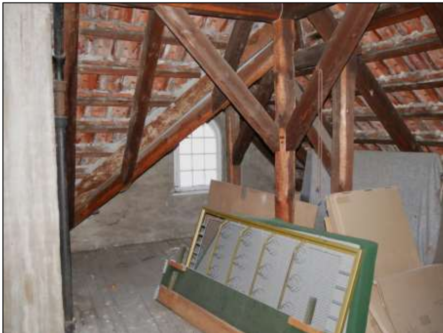
Rohdachboden mit stehendem Fenster nebst Bogensturz im straßen- seitigen Frontspieß hinter einem sogen. Zwerchhaus im Dachraum
