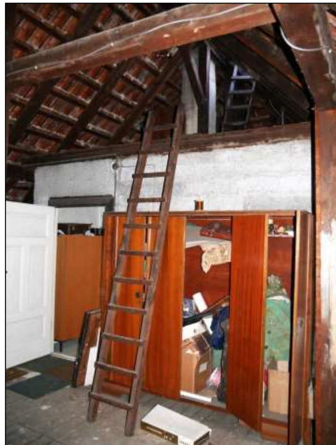
Treppenhauskopf mit Zugang aus dem Vorraum im Dachgeschoss nebst Anstiegleiter zu dem darüber belegenen Spitzboden mit von dort über Anstiegleiter zugänglichem Schornsteinfeuerschieber
