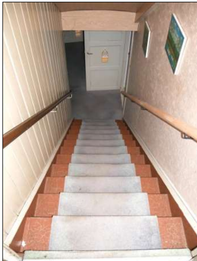
Eingehauster Kellertreppen- abgang mit Blick durch die Sperrtür im Hochparterre
