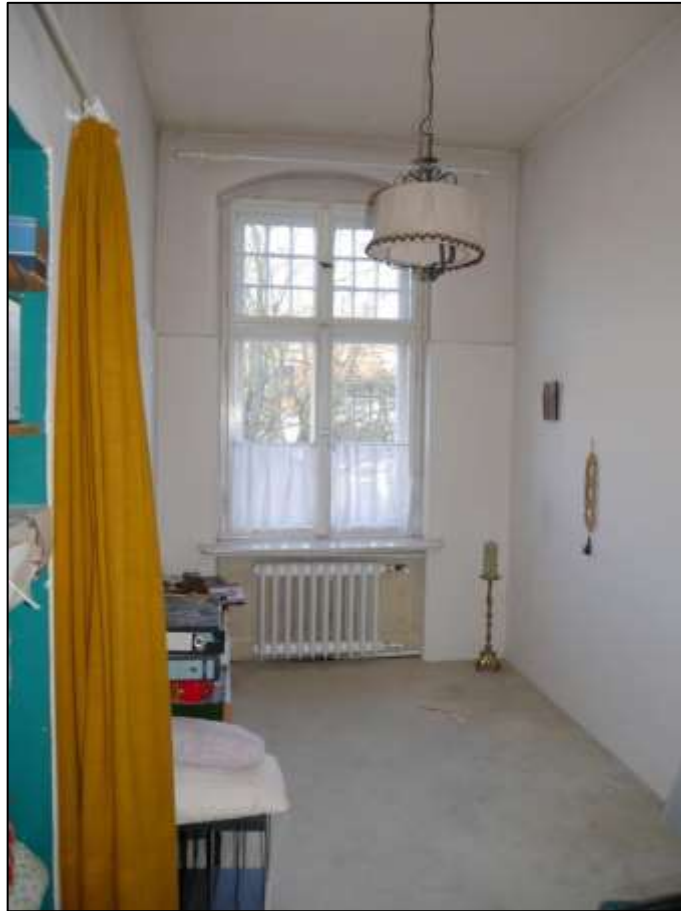
gegenüber dem Treppenaustritt im Obergeschoss an die Diele anbindendes straßenseitiges Zimmer
