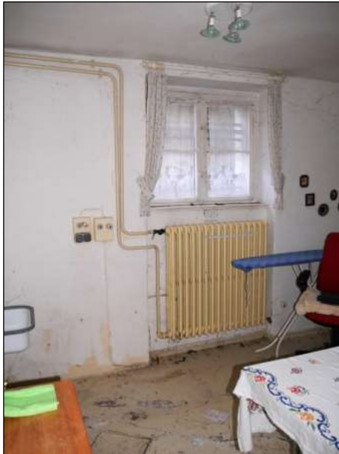
ehemalige Waschküche vor der zum linken Bauwich orientierte Gebäudefront im Keller- geschoss mit über Terrain lie- gendem Fenster
